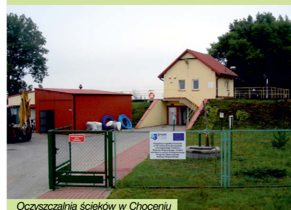
Oczyszczalnia ścieków w Choceniu
