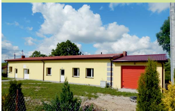
Wyremontowany i zmodernizowany budynek społeczno-kulturalny w miejscowości Okalewko
