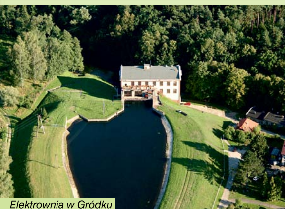
Elektrownia w Gródku
