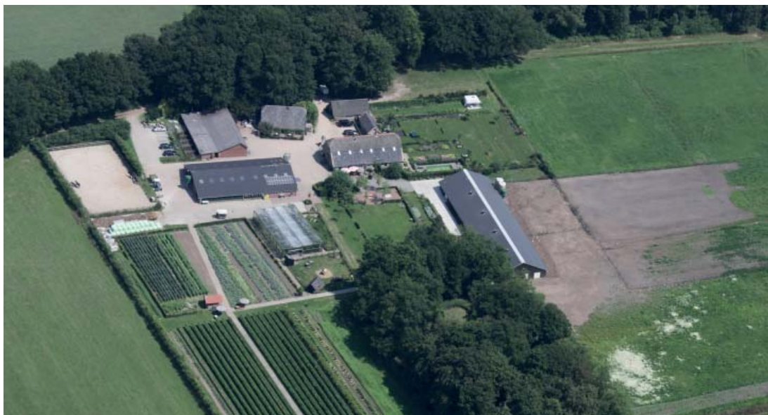
Widok ogólny gospodarstwa wielofunkcyjnego. Na zdjęciu budynki gospodarcze, dla zwierząt a także pomieszczenia oraz teren przeznaczony na prowadzenie zajęć
