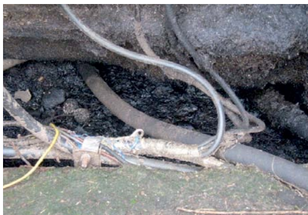
Warstwa plew zanieczyszczonych olejem stwarza zagrożenie pożarowe
