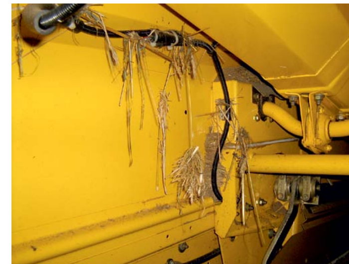
Resztki słomy przyciągają gryzonie, co grozi uszkodzeniem instalacji elektrycznej
