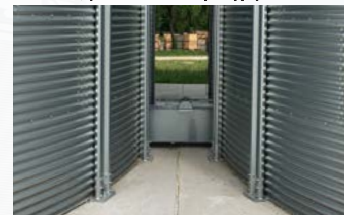
REDLER W KANALE WENTYLACYJNYM
