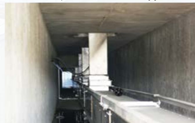
REDLER W KANALE PRZEŁAZOWYM
