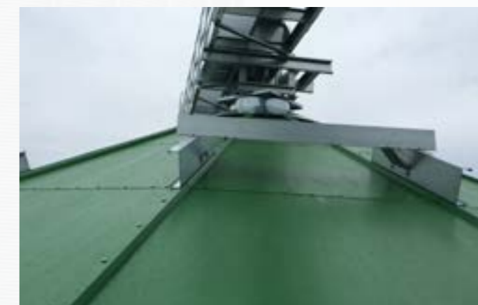
DACH POKRYTY WARSTWĄ SOLANO
