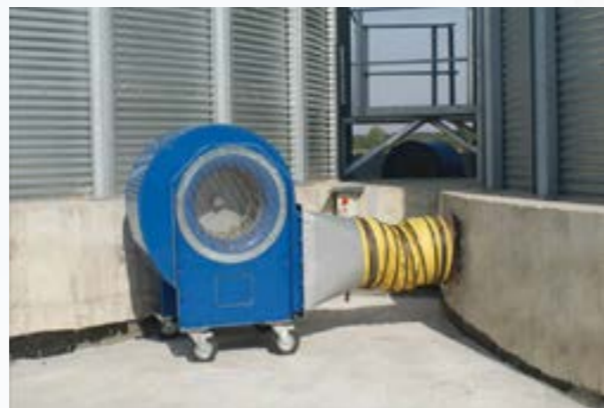
WENTYLATOR PRZY FUNDAMENCIE WYNIESIONYM
