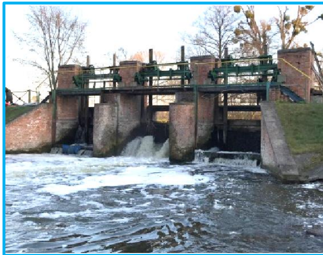
Jaz Antoniewo – widok od strony dolnej wody (stan przed rozpoczęciem robót budowlanych)
