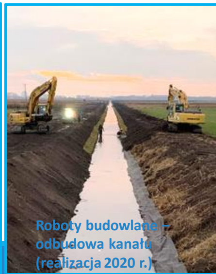
Roboty budowlane – odbudowa kanału (realizacja 2020)
