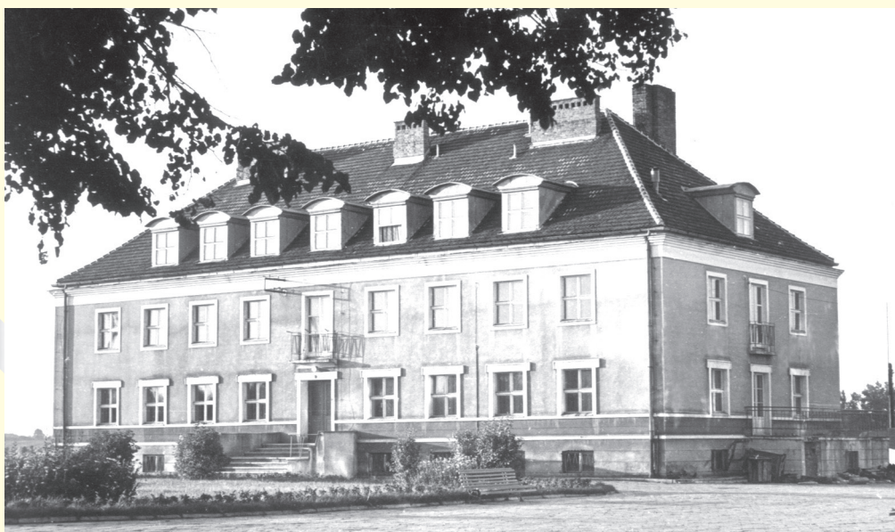
Zdjęcie nr 1. Budynek biurowy RRZD w Minikowie, lata 60. (Źródło: archiwum zakładowe).
