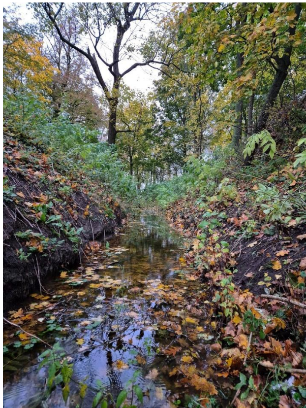
Fot. 6.4.2.5. Rów odprowadzający wodę ze zbiornika (fot. 28.10.2025)
