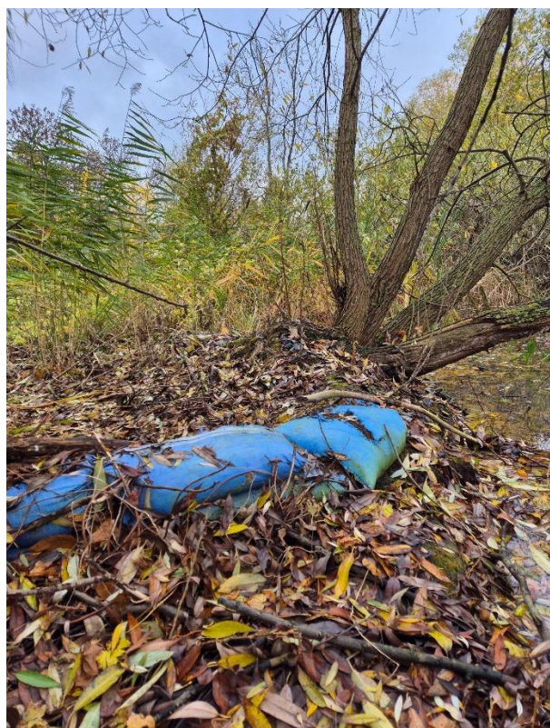
Fot. 6.4.1.4. Wlot do przepustu o średnicy 60 cm na wylocie ze zbiornika, widok od strony wody górnej. Wlot jest tymczasowo zablokowany workami z piaskiem.
