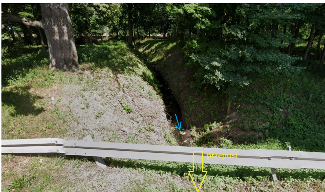
Fot. 6.4.2.7. Odcinek rowu poniżej zbiornika przed wlotem do przepustu pod drogą wojewódzką nr 266 (Źródło: Google Street View)
