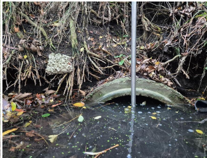
Fot. 6.4.1.2. Widok na fotografii od strony wody górnej wlotu do zbiornika – przepust o średnicy 50 cm pod jezdnią ul. M. Wodzyńskiej poniżej kładki/mostu. Przepust uszkodzony i zamulony w 50%.
