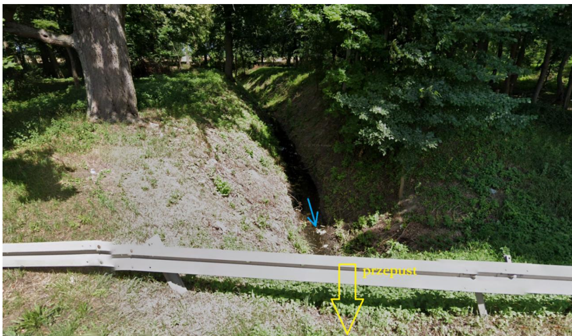
Fot. 6.4.2.7. Odcinek rowu poniżej zbiornika przed wlotem do przepustu pod droga wojewódzką nr 266: źródło: Google Street View
