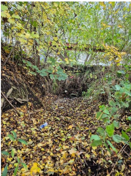
Fot. 6.4.1.2. Widok na fotografii od strony wody górnej wlotu do zbiornika – przepust o średnicy 50 cm pod jezdnią ul. M. Wodzyńskiej poniżej kładki/mostu. Przepust uszkodzony i zamulony w 50%.
