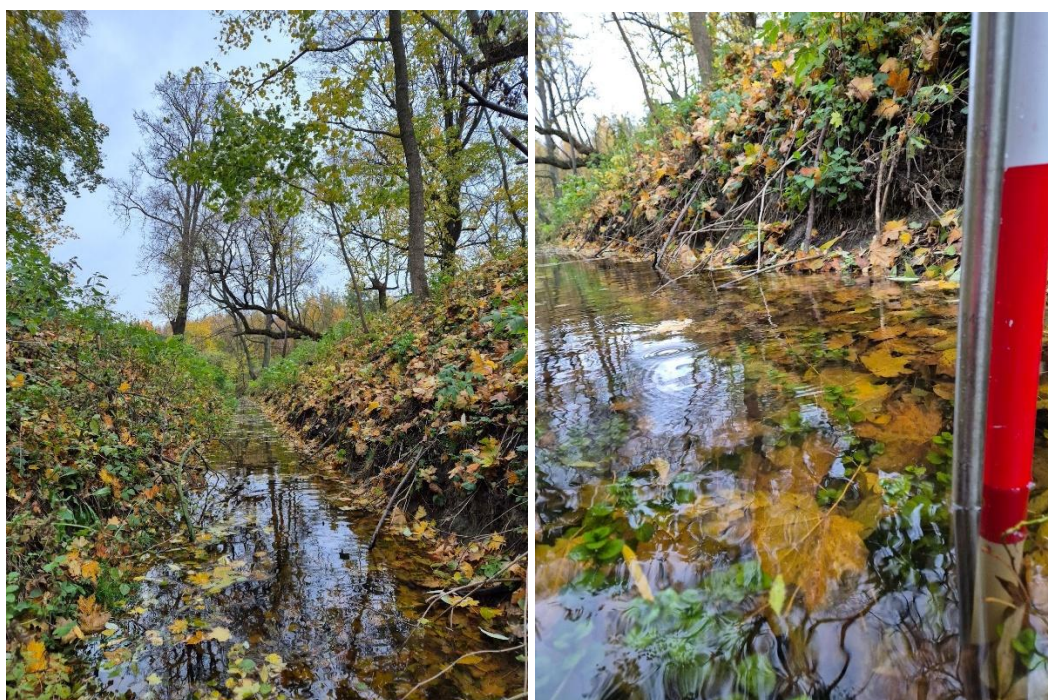
Fot. 6.4.2.4. Rów doprowadzający wodę do zbiornika od strony północnej (fot. 28.10.2025)
