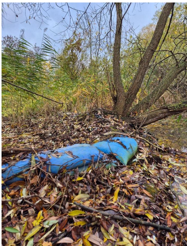
Fot. 6.4.1.4. Wlot do przepustu o średnicy 60 cm na wylocie ze zbiornika, widok od strony wody górnej. Wlot jest tymczasowo zablokowany workami z piaskiem.
