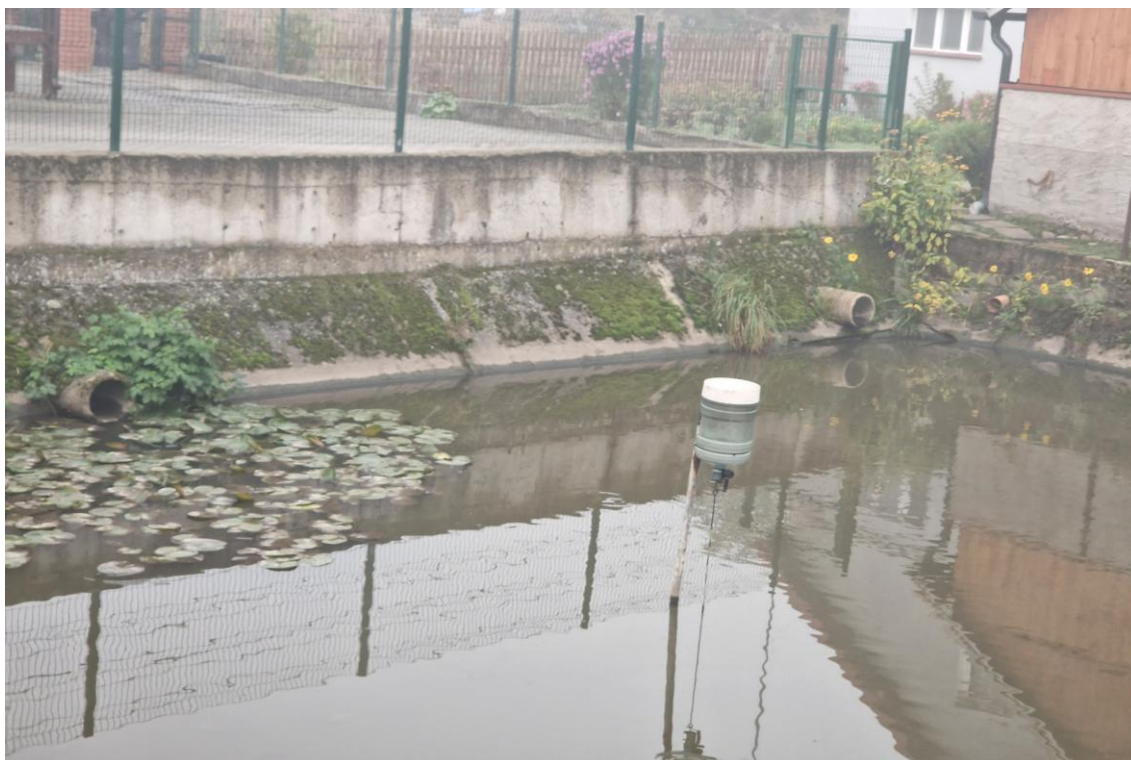
Fot. 6.4.1.6. Zbiornik zamulony w wschodniej części na około 20 cm, głębokość podczas wizyty terenowej 30.10.2025 r. wynosiła 55 cm. Połączony z rowem prowadzącym dopływ do Jeziora Górzyńskiego.
