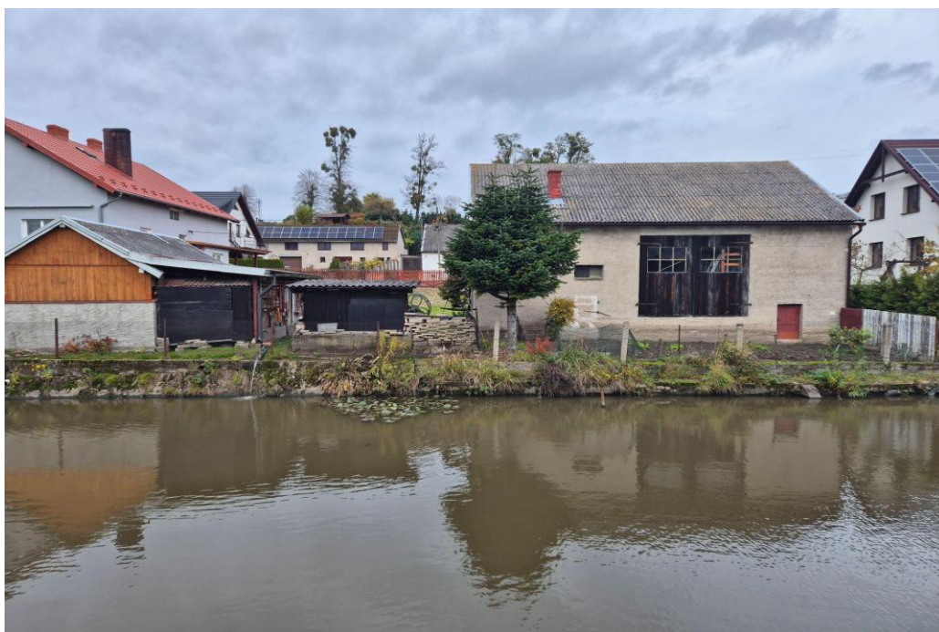
Fot. 6.4.1.2. Widok na zbiornik od strony ul. Matejki.
