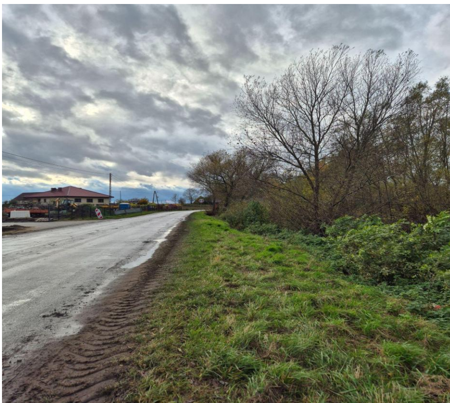
Fot. 6.4.2.4. Woda do zbiornika sływa bezpośrednio z drogi. Po drugiej stronie drogi (działka 119/4) znajduje się stacja uzdatniania wody, trwa budowa nowej studni.
