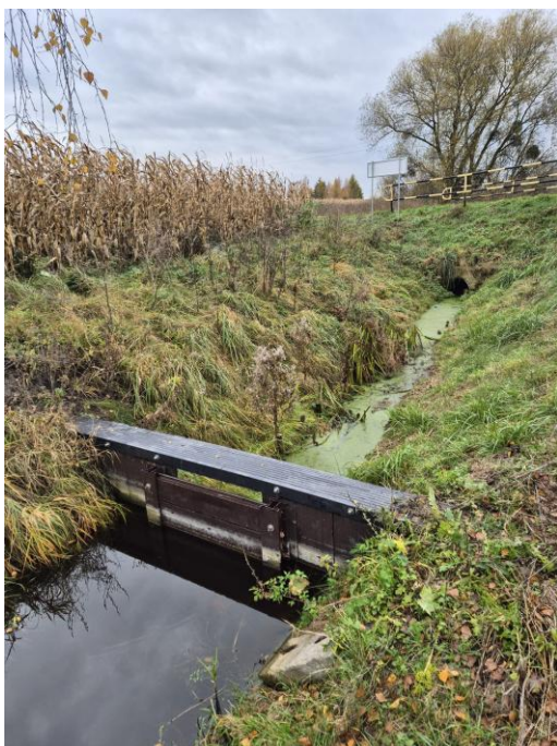
Fot. 6.4.1.2. Zastawka na działce 134/4 na rowie melioracyjnym zwykłym w m. Wudzynek, powyżej użytku ekologicznego - rzędne zwierciadła wody w. górna= 91.233 woda dolna=90.964
