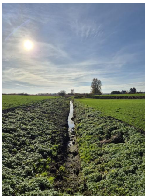
Fot. 6.4.1.1. Odcinek rowu melioracyjnego na działce 120, 121 i 122 doprowadzający wodę do Użytku Ekologicznego.
