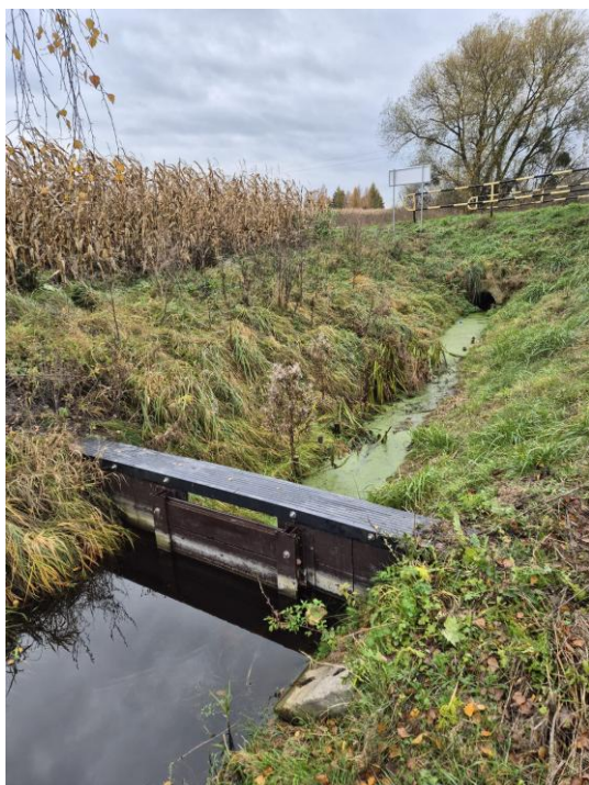
Fot. 6.4.1.2. Zastawka na działce 134/4 na rowie melioracyjnym zwykłym w m. Wudzynek, powyżej użytku ekologicznego - rzędne zwierciadła wody w. górna= 91,233; woda dolna=90,964
