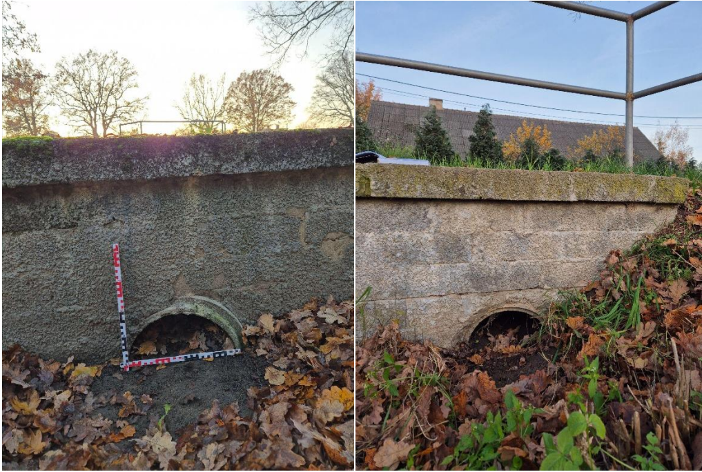
Fot. 6.4.2.3. Przepust 1 doprowadzający wodę do Zbiornika nr 1
