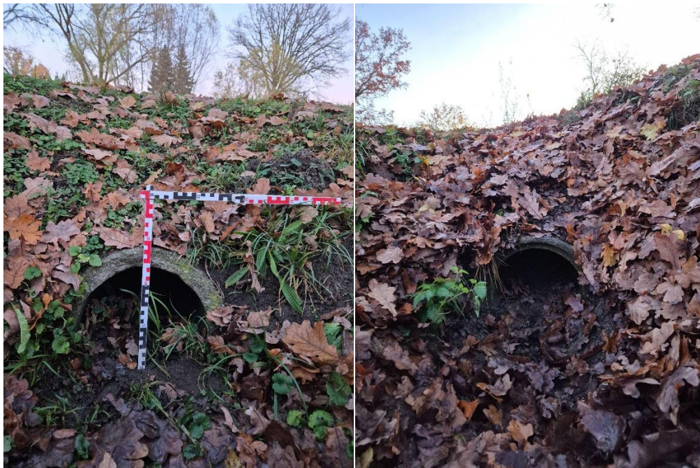
Fot. 6.4.2.7. Do Zbiornika nr 2 wody uchodzą dwoma niewielkimi przepustami z rowów wzdłuż jezdni.
