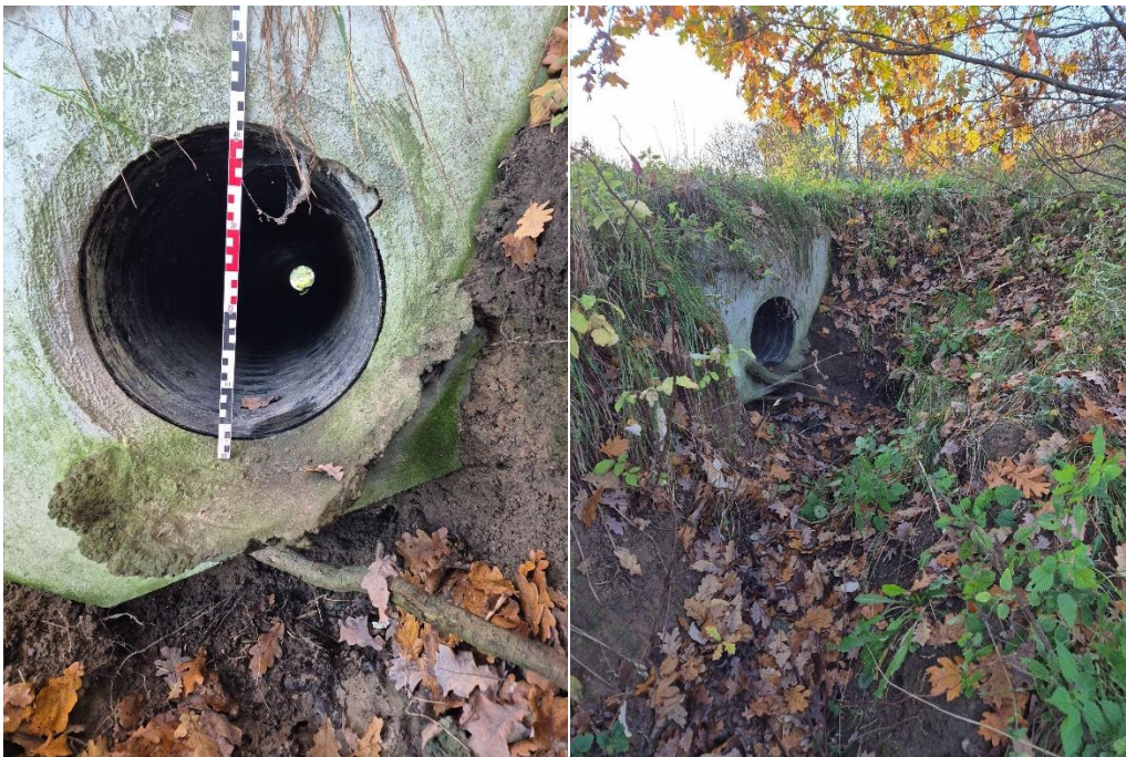
Fot. 6.4.2.4. Przepust 2 doprowadzający wodę do Zbiornika nr 1
