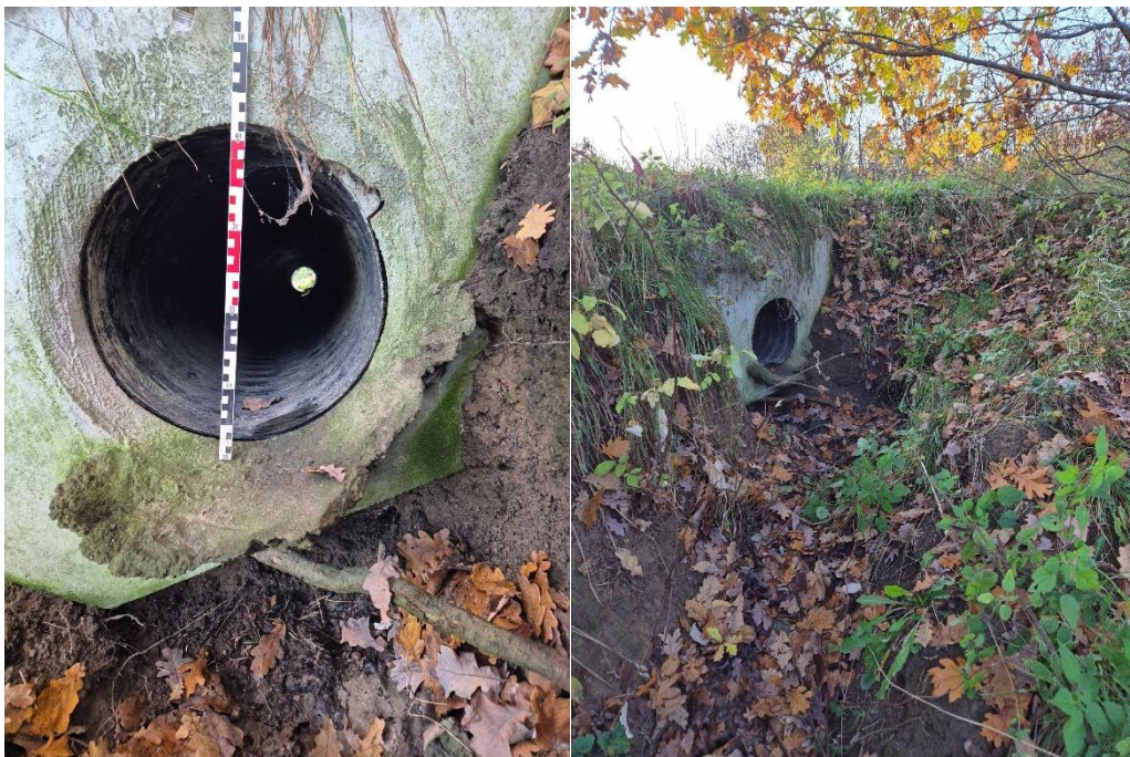
Fot. 6.4.2.4. Przepust 2 doprowadzający wodę do Zbiornika nr 1.
