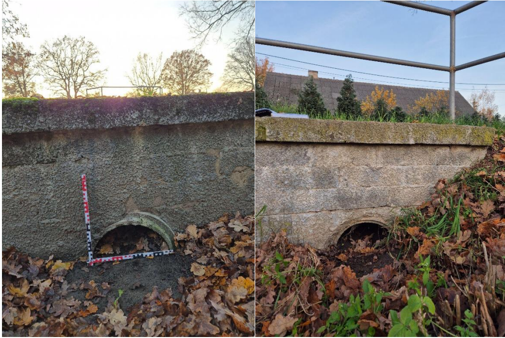
Fot. 6.4.2.3. Przepust 1 doprowadzający wodę do Zbiornika nr 1.
