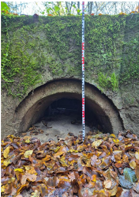
Fot. 6.4.1.5. Odpływ wody ze Zbiornika 1 Przepust o średnicy 80 cm na wylocie ze Zbiornika nr 1
