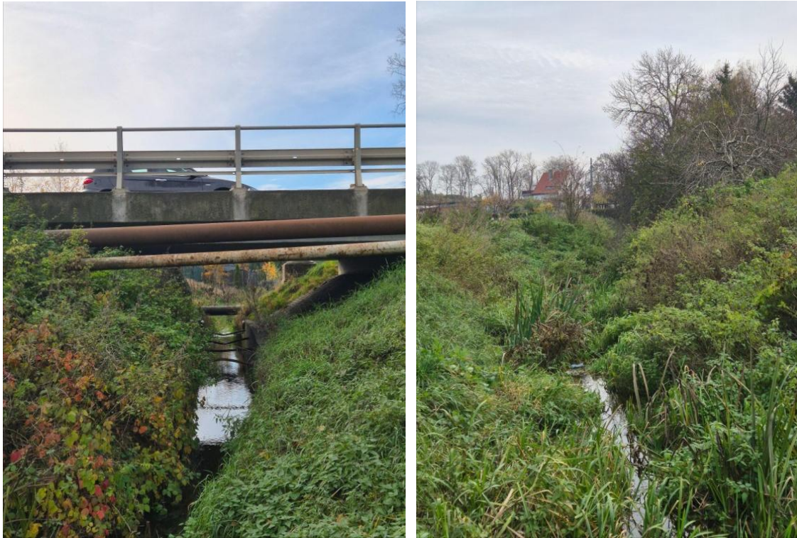
Fot. 6.4.2.1. Radzyńska Struga widok na most na drodze 534 i z mostu w stronę jeziora.
