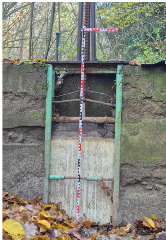
Fot. 6.4.1.4. Urządzenie na wlocie do Zbiornika nr 1. Dno zastawki 66,536 m 53^{\circ}22'01.8101''N 18^{\circ}44'35.6352''E .
