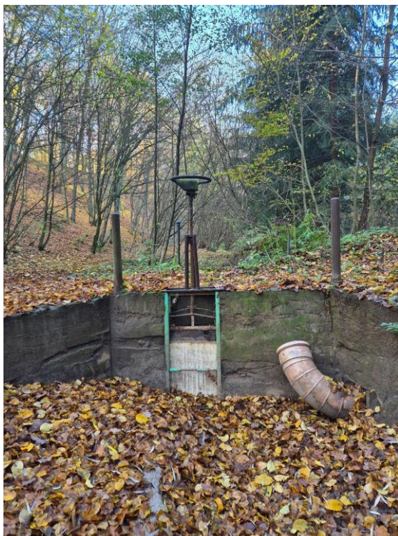
Fot. 6.4.1.4. Urządzenie na wlocie do Zbiornika nr 1. Dno zastawki 66,536 m 53^{\circ}22'01.8101''N 18^{\circ}44'35.6352''E .
