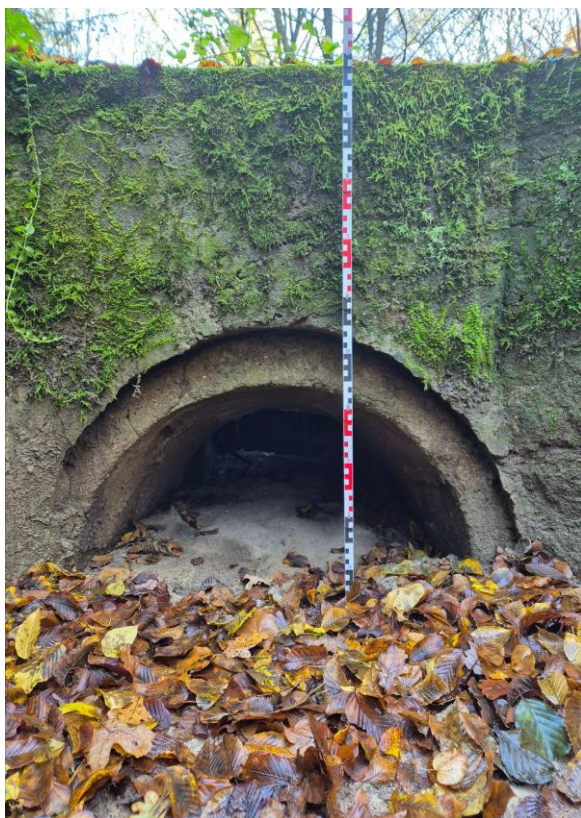
Fot. 6.4.1.5. Odpływ wody ze Zbiornika 1 Przepust o średnicy 80 cm na wlocie ze Zbiornika nr 1
