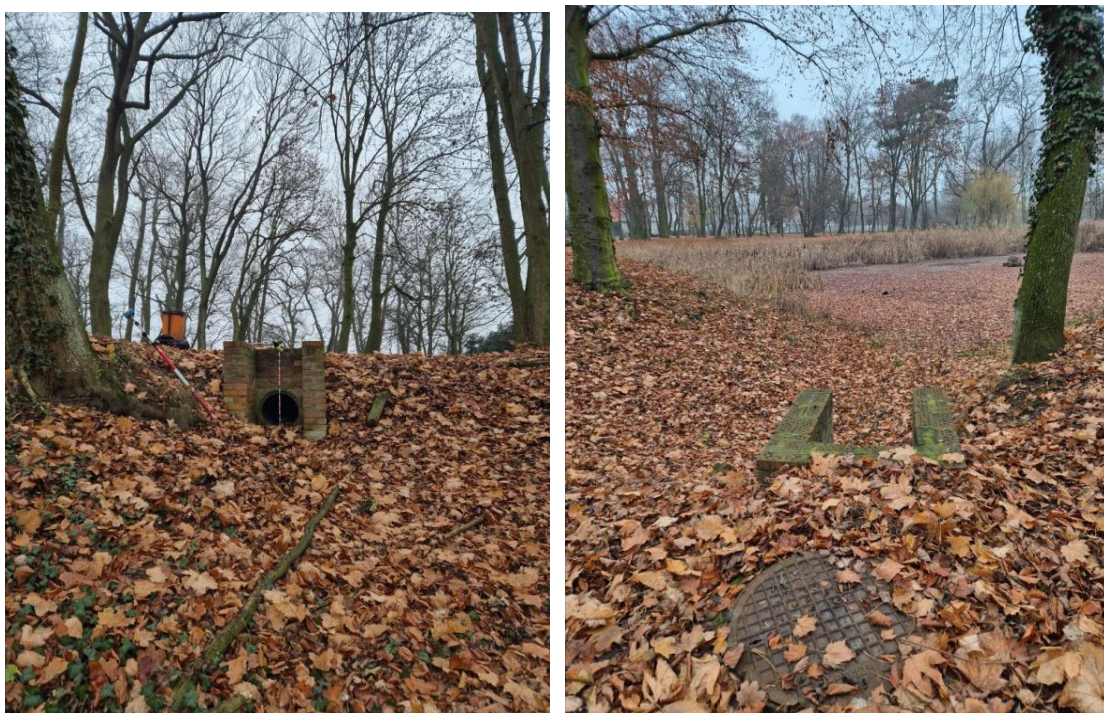
Fot. 6.4.2.4. Studzienka doprowadzająca wodę do zbiornika na działce 25/9, obręb Kołuda Wielka, do odbudowy, (fot. 25.11.2025). Rzędna dna wylotu = 81.622 m n.p.m. ( 52^{\circ}44'03.4505''\text{N} 18^{\circ}09'10.9842''\text{E} ).
