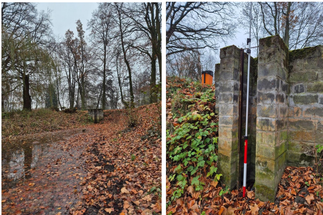
Fot. 6.4.2.3. Mnich na połączeniu zbiorników na działce 25/9, obręb Kołuda Wielka. Nieczynna, do odbudowy – dno zastawki = 79.829 m n.p.m. ( 52^{\circ}44'03.8419''N 18^{\circ}09'14.8404''E ).
