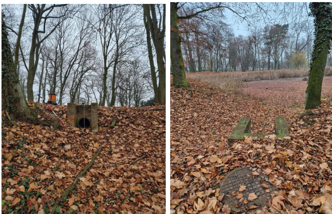
Fot. 6.4.2.4. Studzienka doprowadzająca wodę do zbiornika na działce 25/9, obręb Kołuda Wielka, do odbudowy (fot. 25.11.2025). Rzędna dna wylotu = 81.622 m n.p.m. ( 52^{\circ}44'03.4505''N 18^{\circ}09'10.9842''E ).
