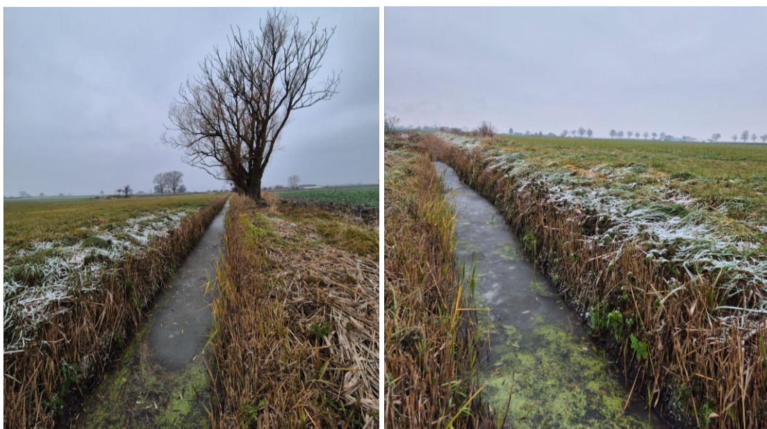
Fot. 6.4.1.1. Rów (Dopływ z bagna Błoto Ostrowickie) w proponowanej lokalizacji. Zwierciadło wody w dn. 20.11. 2025 wynosiło 82.425 m n.p.m., a dno ciek. 82.005 m n.p.m.
