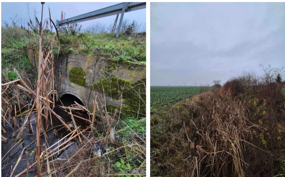
Fot. 6.4.1.4. Przepust na działce drogowej 18/, poniżej planowanego zbiornika na drodze, rów przed przepustem, dno przepustu 82.084 m n.p.m, zwierciadło wody 82.733 m n.p.m.
