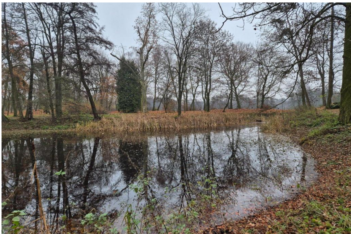
Fot. 6.4.2.5. Czasza zbiornika nr 2 na działce 25/9, obręb Kołuda Wielka (fot. 25.11.2025). Rzędna zwierciadła wody = 80.048 m n.p.m.
