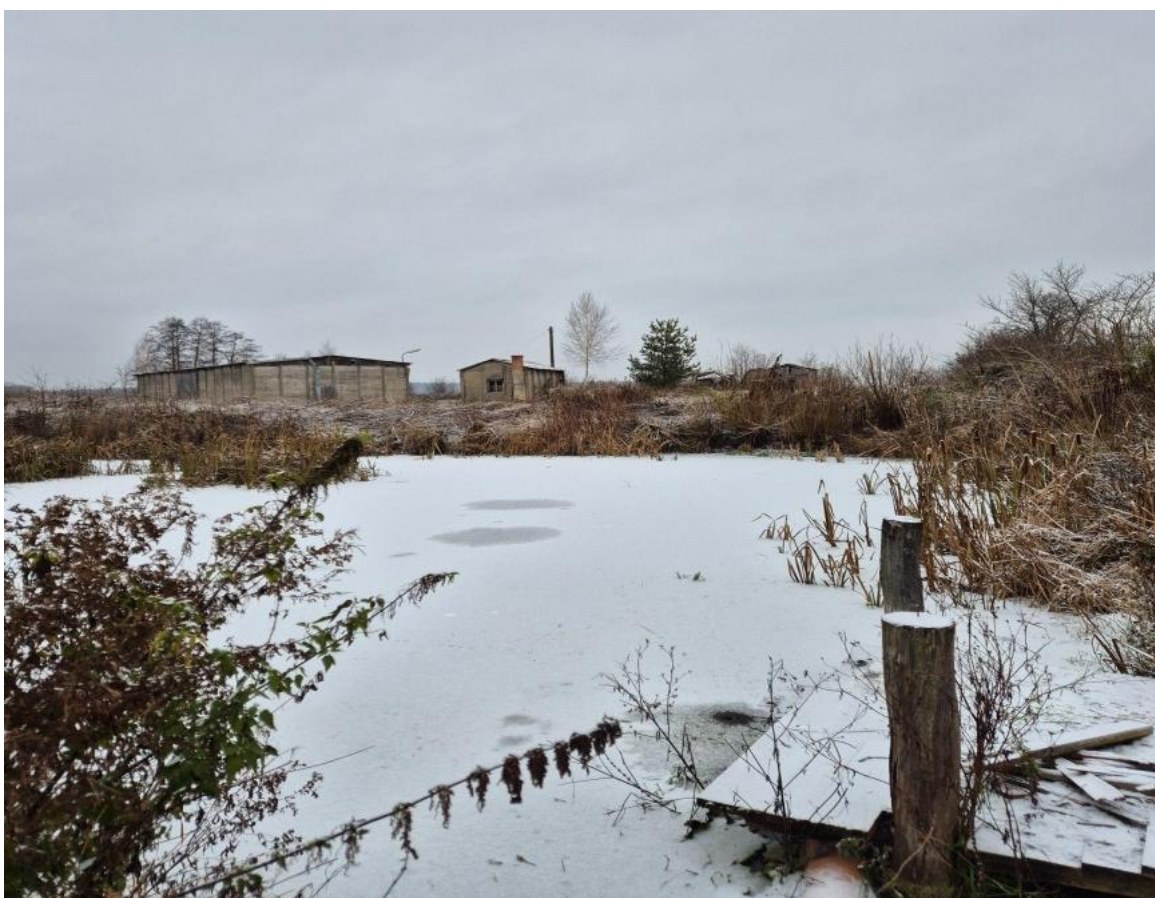
Fot. 6.4.1.2. Zbiornik widok od strony drogi .
