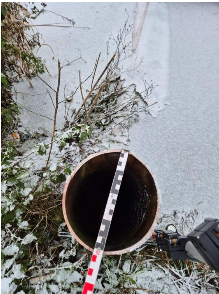
Fot. 6.4.1.5. Nadmiar wód ze zbiornika po jego spiętrzeniu do rzędnej drogi wpływa do rury PCV o średnicy 20 cm, dno rury = 105.317 m n.p.m.
