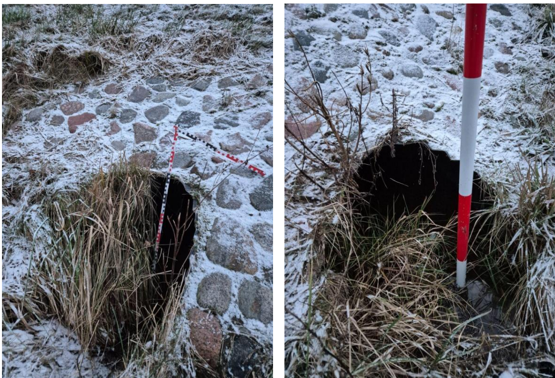
Fot. 6.4.1.12. Przepust pod DW 559 - dno przepustu powyżej drogi rzędna 107.863 m n.p.m. ( 52^{\circ}45'17.1576''N 19^{\circ}23'14.6996''E ), dno przepustu poniżej drogi (przed ścieżką pieszo-rowerową) rzędna 107.835 m n.p.m. ( 52^{\circ}45'17.3446''N 19^{\circ}23'15.7868''E ).
