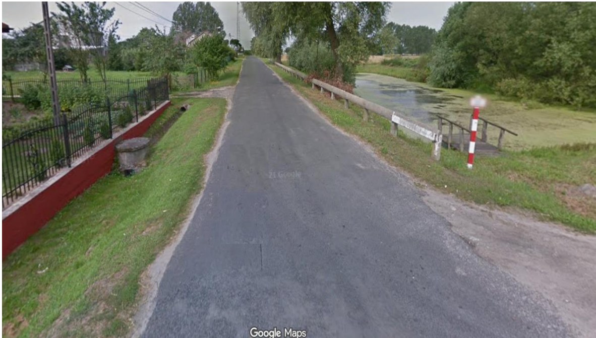
Fot. 6.4.1.4. Droga 3428C nad przepustem odprowadzającym wodę ze zbiornika
