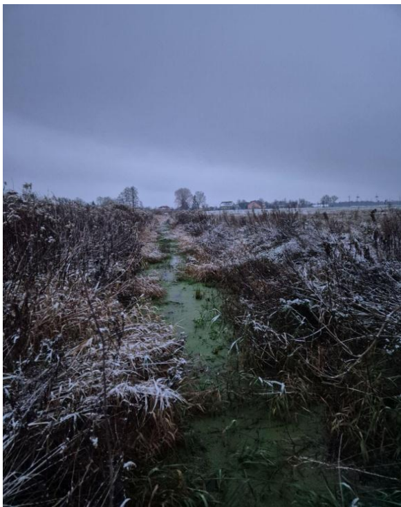
Fot. 6.4.1.11. Początek rowu otwartego - lustro wody = 106.013 m n.p.m. (52°45'05.8832"N 19°23'41.0203"E), dno rowu = 105.395 m n.p.m. (52°45'07.6225"N 19°23'39.2650"E).
