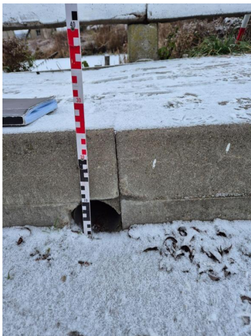
Fot. 6.4.1.8. Odprowadzenie wody z drogi powiatowej 3428C - dno rzędna 106.825 m n.p.m. (52°44'59.3179"N 19°23'49.8524"E).
