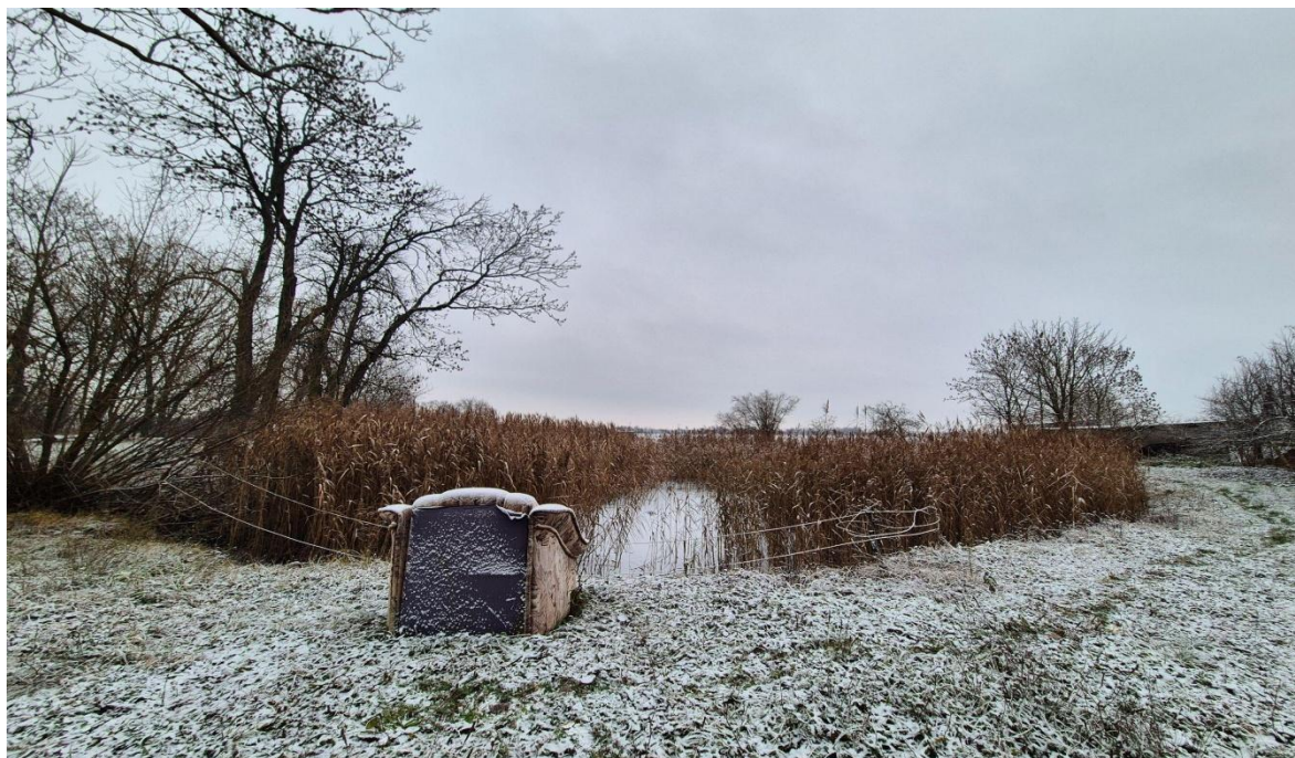
Fot. 6.4.1.2. Widok na zbiornik od strony północnej
