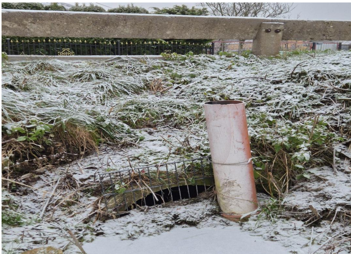
Fot. 6.4.1.3. Przepust pod droga gminną – dno odpływu = 105.236 m n.p.m. (zamulony w 2/3 i niedrożny).
