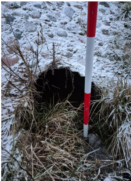
Fot. 6.4.1.12. Przepust pod DW 559 – dno przepustu powyżej drogi rzędna 107.863 m n.p.m. ( 52^{\circ}45'17.1576''\text{N} 19^{\circ}23'14.6996''\text{E} ), dno przepustu poniżej drogi (przed ścieżką pieszo-rowerową) rzędna 107.835 m n.p.m. ( 52^{\circ}45'17.3446''\text{N} 19^{\circ}23'15.7868''\text{E} ).
