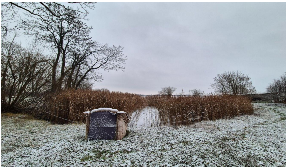
Fot. 6.4.1.2. Widok na zbiornik od strony północnej
