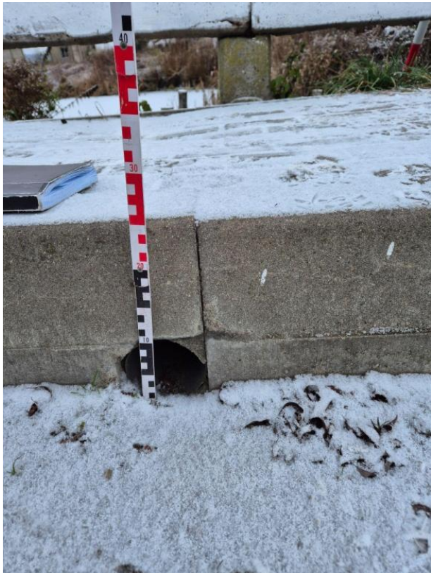
Fot. 6.4.1.8. Odprowadzenie wody z drogi powiatowej 3428C – dno rzędna 106.825 m n.p.m. ( 52^{\circ}44'59.3179''N 19^{\circ}23'49.8524''E ).
