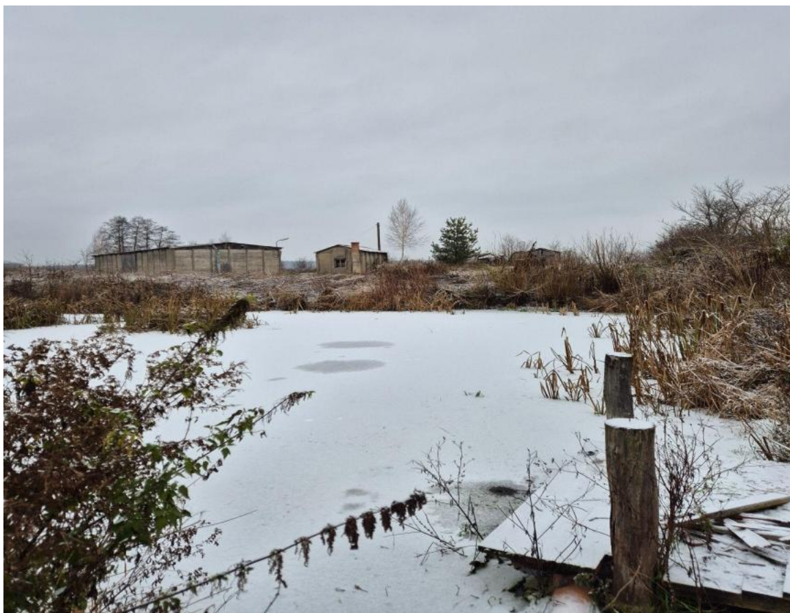
Fot. 6.4.1.2. Zbiornik widok od strony drogi.
