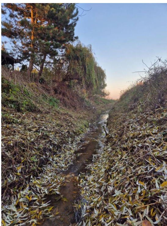
Fot. 6.4.2.4. Uregulowane koryto Strugi Faluskiej powyżej Jeziora Białego
