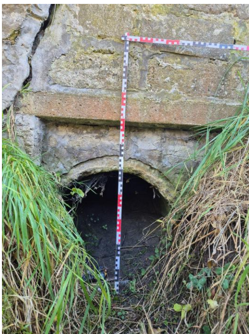
Fot. 6.4.1.6. Przepust o średnicy 100 cm na rowie w miejscu planowanego przereztu.
