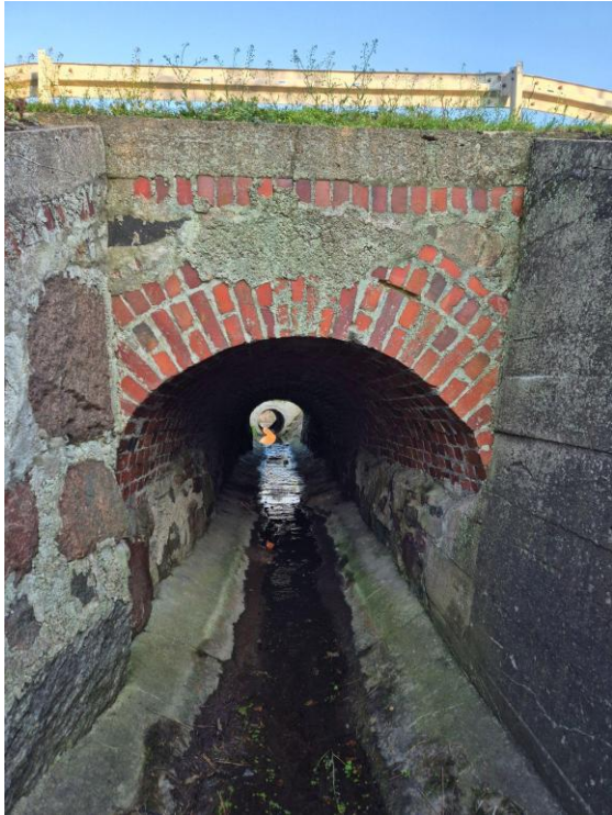
Fot. 6.4.2.5. Przepust na Strudze Faluskiej bezpośrednio powyżej jeziora, rzędna 101,11 m.
