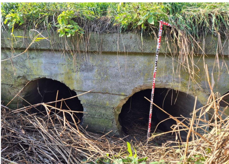
Fot. 6.4.1.3. Przepust podwójny o średnicy 120 cm na rowie doprowadzającym wodę do Jeziora - dno 99.268, 52°31'43.3026"N 18°10'55.8486"E.
