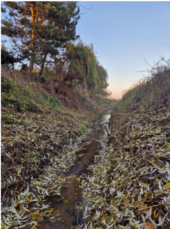
Fot. 6.4.2.4. Uregulowane koryto Kanalu R-A powyżej Jeziora Białego
