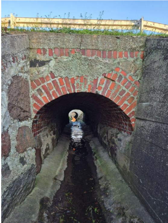
Fot. 6.4.2.5. Przepust na Kanale R-A bezpośrednio powyżej jeziora, rzędna 101,11 m.
