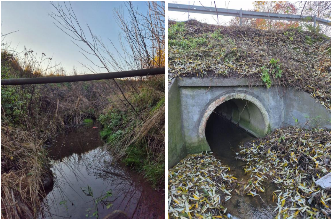
Fot. 6.4.2.3 Koryto Kanalu R-A powyżej Jeziora Białego
