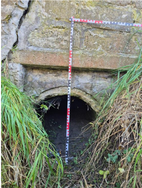
Fot. 6.4.1.6. Przepust o średnicy 100 cm na rowie w miejscu planowanego przerzutu.
