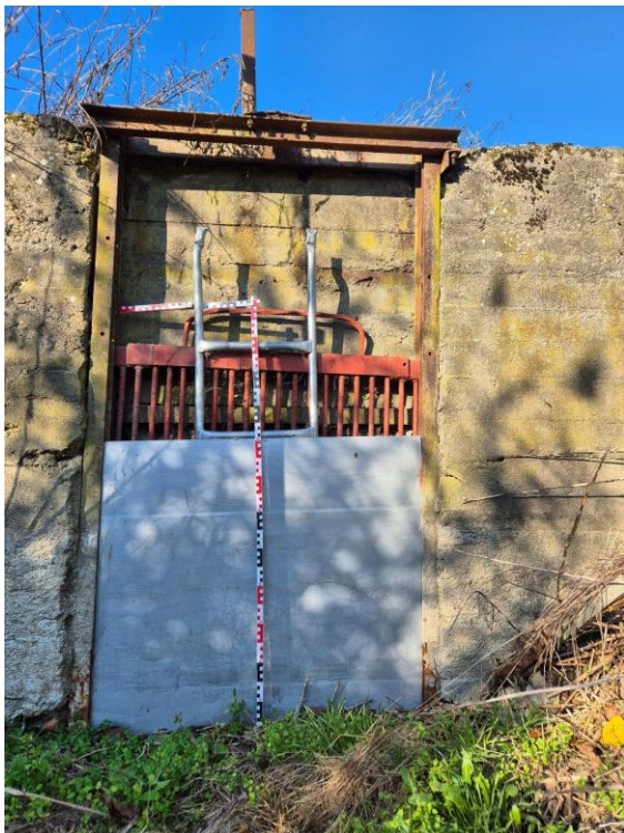
Fot. 6.4.2.6. Zastawka na odpływie z Jeziora Białego. Dno zastawki od strony jeziora rzędna 100.214 m (fotografia po lewej). Ciek poniżej Jeziora Białego - lustro wody 95,278 m, 52°44'58.9129"N 17°56'35.0278"E (fotografia po prawej).
