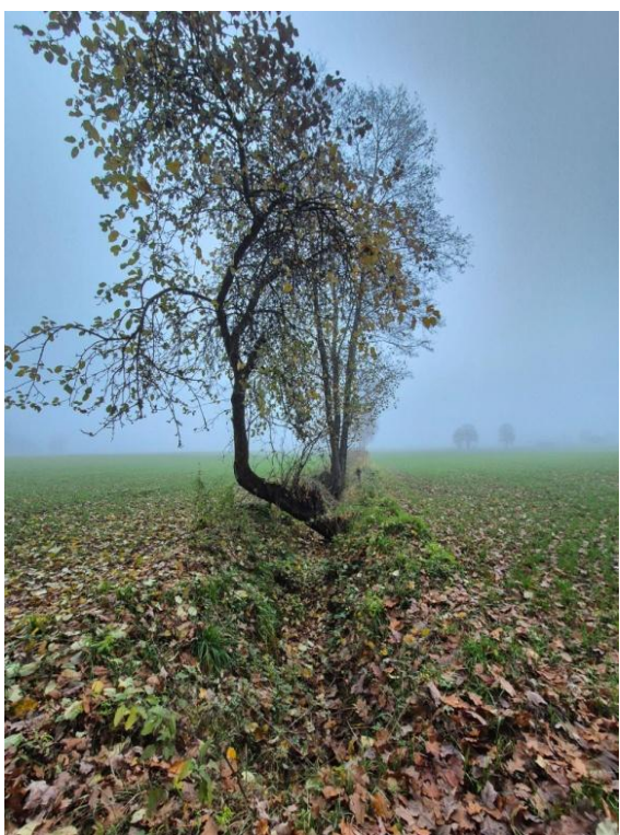
Fot. 6.4.1.1. Przepust o średnicy 50 cm od strony pola oraz widok na rów biegnący przez tereny uprawne.
