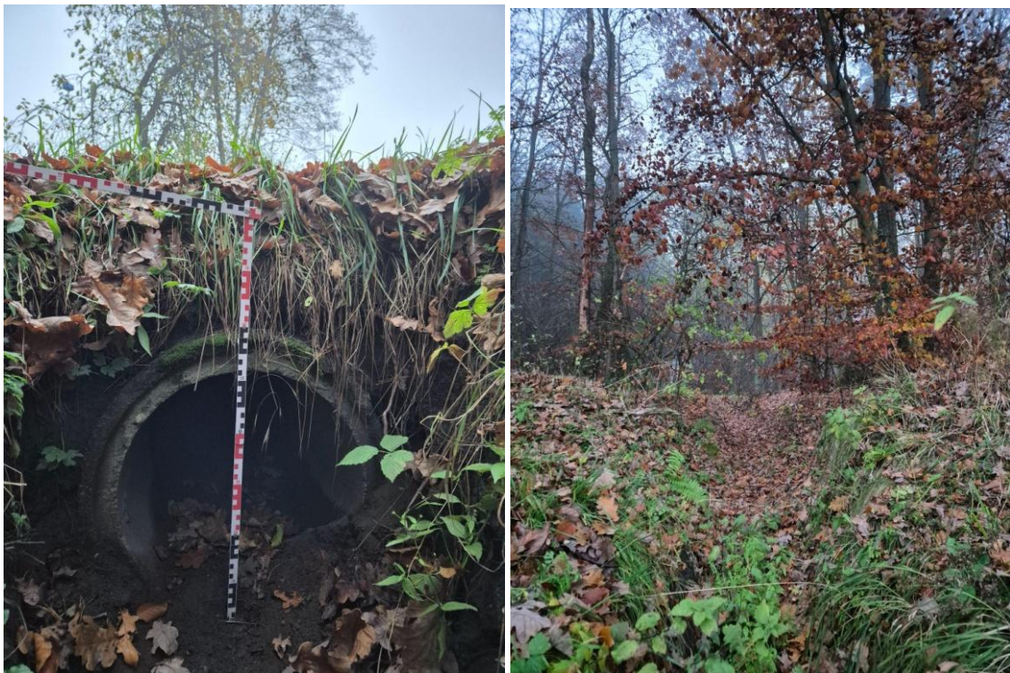
Fot. 6.4.1.2. Przepust o średnicy 50 cm od strony lasu oraz widok na rów po stronie lasu.
