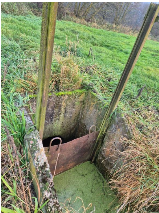
Fot. 6.4.2.3. Przykładowe zastawki jakie funkcjonowały na rowach - działka 164/1. Zastawka Z5 - jedyna kompletna zastawka pod względem wyposażenia. (zdjęcie po prawej).
