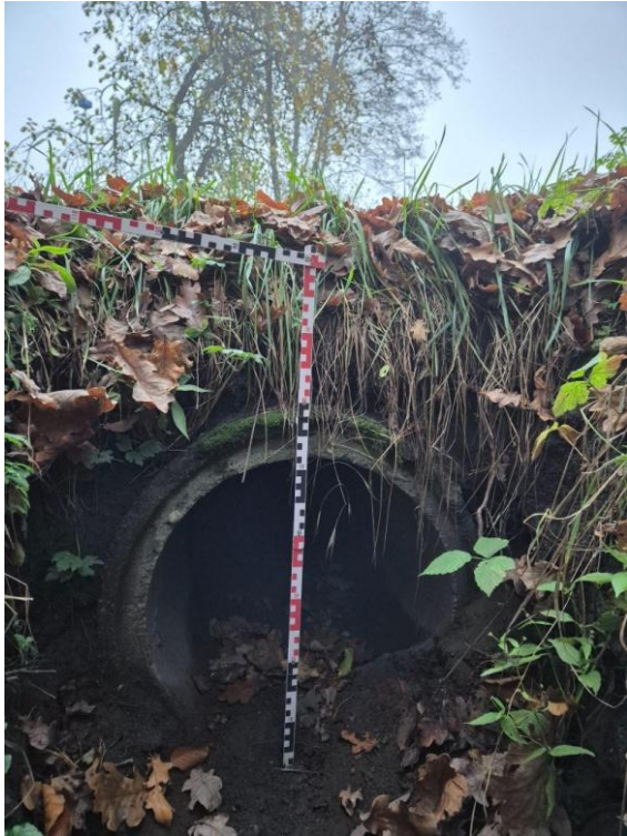
Fot. 6.4.1.2. Przepust o średnicy 50 cm od strony lasu oraz widok na rów po stronie lasu.
