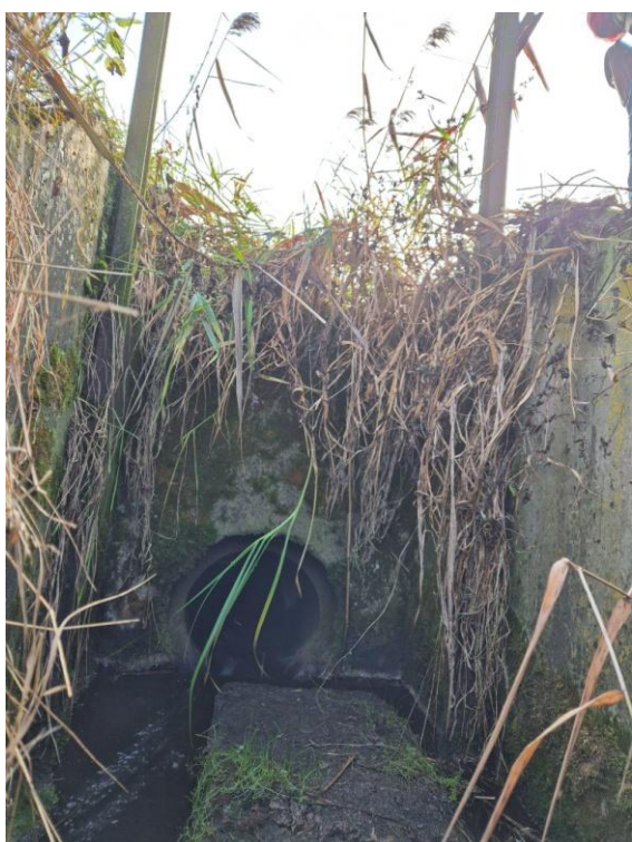
Fot. 6.4.2.1. Przykładowe zastawki - większość pozbawiona metalowych zasuw, a tam gdzie one są, to podobno albo bardzo ciężko chodzą albo wcale są nie do ruszenia na działce 174/1.
