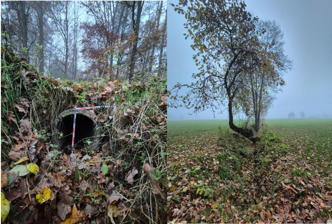
Fot. 6.4.1.1. Przepust o średnicy 50 cm od strony pola oraz widok na rów biegnący przez tereny uprawne.
