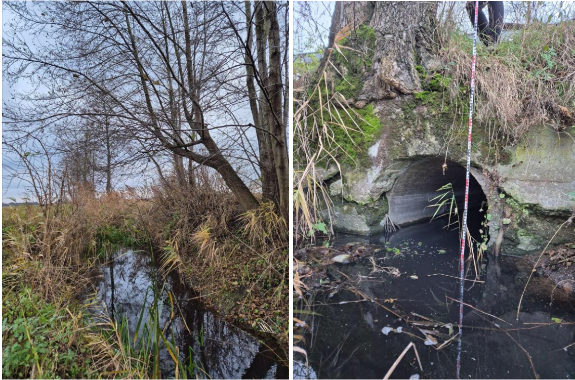
Fot. 6.4.2.7. Rów nr 6, dno przepustu = 98.204 m n.p.m. 52^{\circ}26'20.4029''N , 18^{\circ}40'06.9371''E lustro wody = 98.603 m n.p.m., dno rowu = 98.268 m n.p.m. (muliste)
