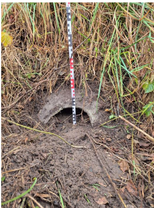
Fot. 6.4.2.2. Rów nr 3. dno rowu = 101.439 m n.p.m. 52°25'50.9852"N, 18°42'16.6792"E, przepust praktycznie zasypany
