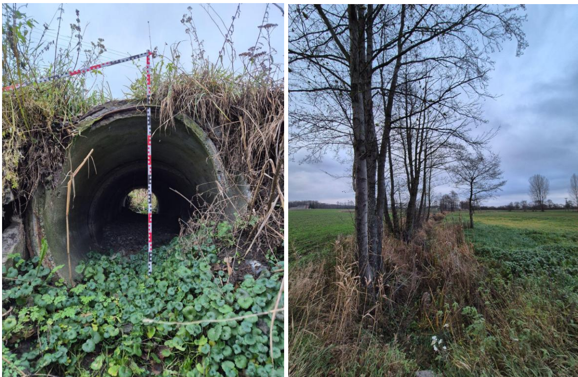
Fot. 6.4.2.8. Rów nr 7, dno przepustu = 98.205 m n.p.m. 52^{\circ}26'32.5276''N , 18^{\circ}39'29.4463''E dno rowu = 97.931 m n.p.m.
