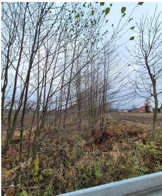
Fot. 6.4.2.4. Rów nr 4 poniżej przepustu
