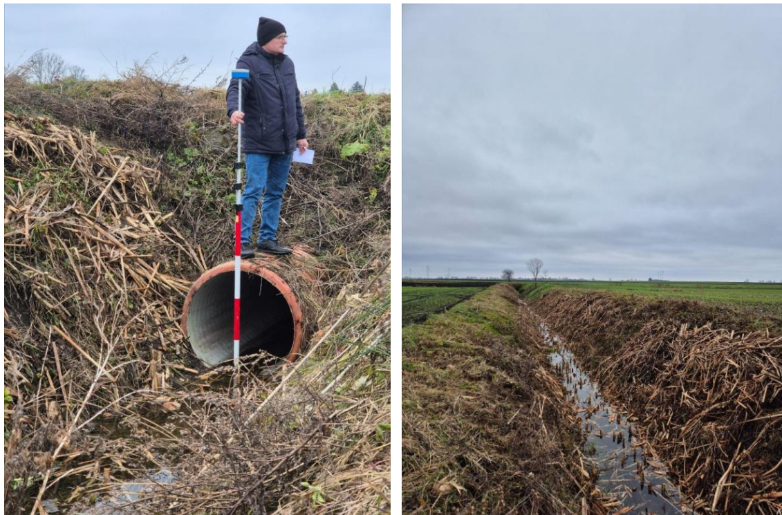
Fot. 6.4.1.1. Rów BA1 – Szostka w profilu projektowanej zastawki oraz powyżej przepustu, gdzie planowana jest zastawka (dz. nr 118/1 i 223). Dno przepustu = 92.627
