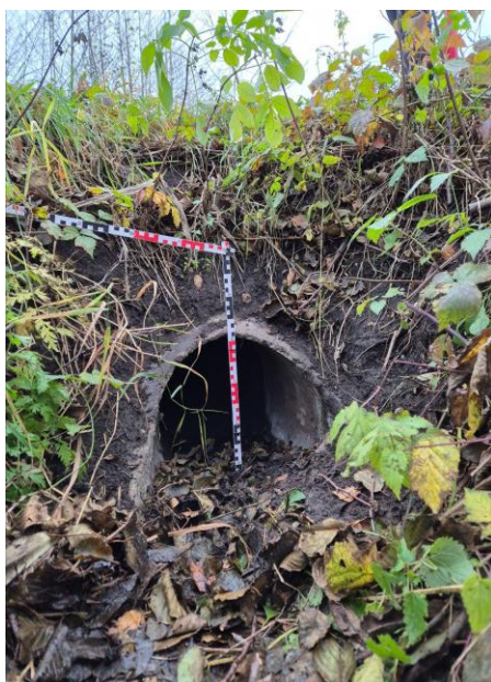
Fot. 6.4.2.3. Rów nr 4. dno przepustu = 101.025 m n.p.m 52°25'31.2462"N, 18°42'32.3517"E; skarpy rowu porośnięte drzewami
