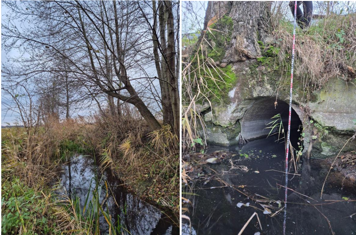
Fot. 6.4.2.7. Rów nr 6, dno przepustu = 98.204 m n.p.m; 52°26'20.4029"N, 18°40'06.9371"E lustro wody = 98.603 m n.p.m., dno rowu = 98.268 m n.p.m. (muliste)
