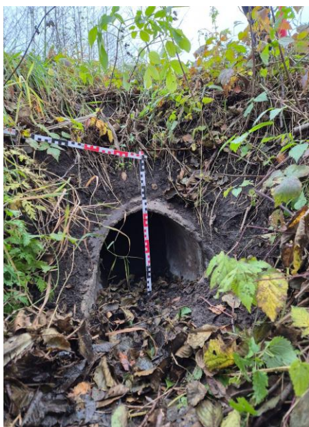
Fot. 6.4.2.3. Rów nr 4. dno przepustu = 101.025 m n.p.m; 52^{\circ}25'31.2462''N , 18^{\circ}42'32.3517''E ; skarpy rowu porośnięte drzewami.
