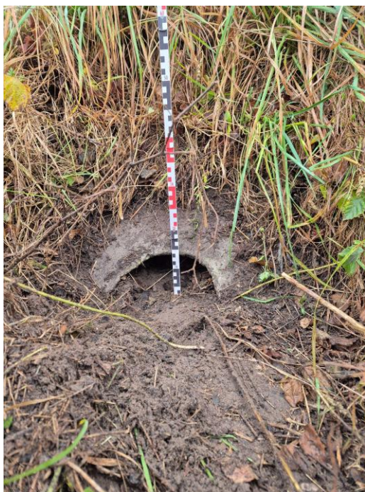
Fot. 6.4.2.2. Rów nr 3. dno rowu = 101.439 m n.p.m; 52^{\circ}25'50.9852''N , 18^{\circ}42'16.6792''E , przepust praktycznie zasypany.
