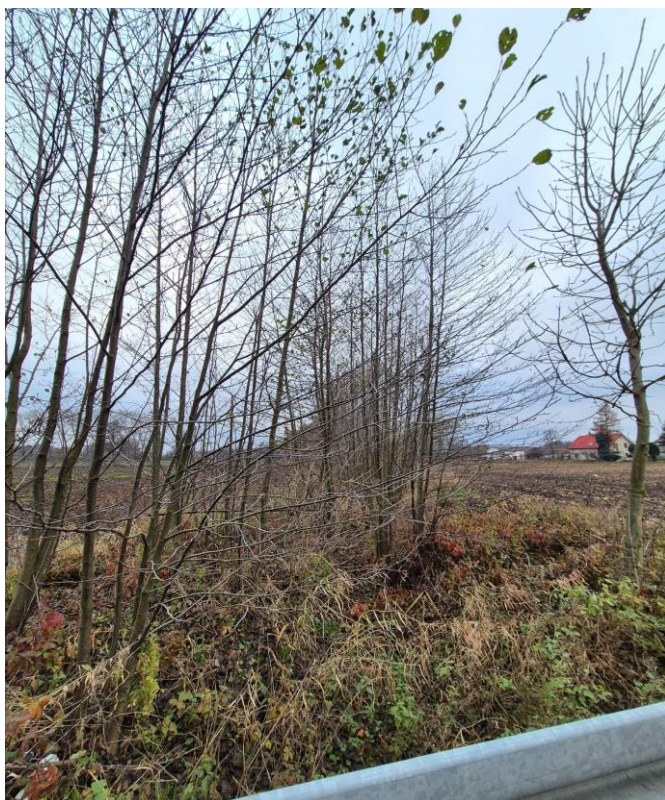
Fot. 6.4.2.4. Rów nr 4 poniżej przepustu
