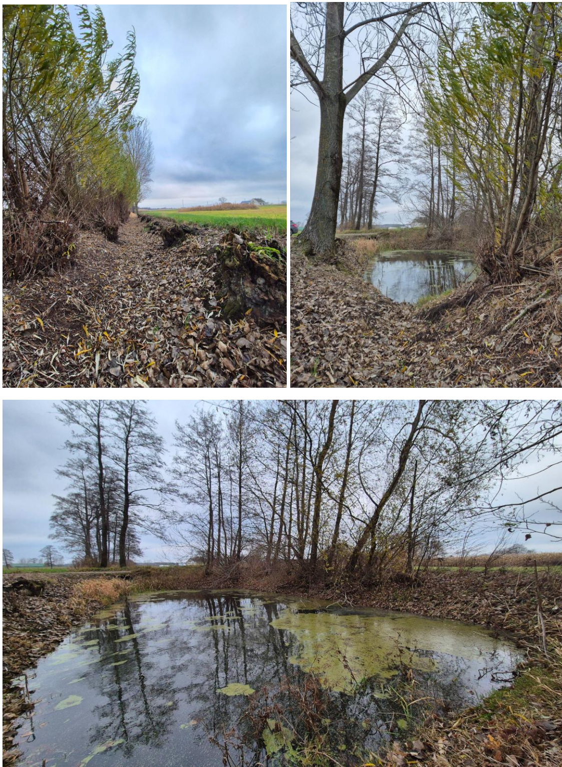
Fot. 6.4.2.5. Rów nr 5, rów powyżej przepustu, zaraz przed przepustem mały zbiornik/oczko.
