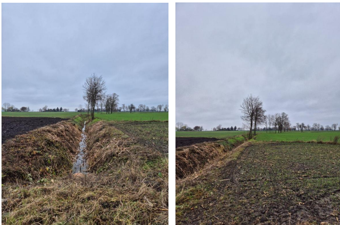
Fot. 6.4.1.2. Rów BA1 w odcinku poniżej przepustu pod działką drogową.
