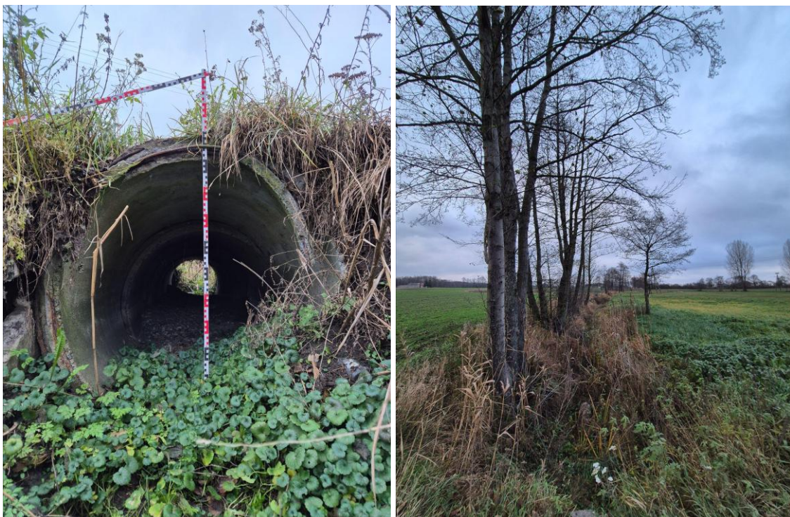
Fot. 6.4.2.8. Rów nr 7, dno przepustu = 98.205 m n.p.m; 52°26'32.5276"N, 18°39'29.4463"E dno rowu = 97.931 m n.p.m.
