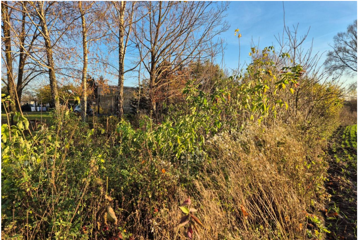
Fot. 6.4.1.3 Zarośnięty rów wzdłuż granicy działek 197/42 i 197/3
