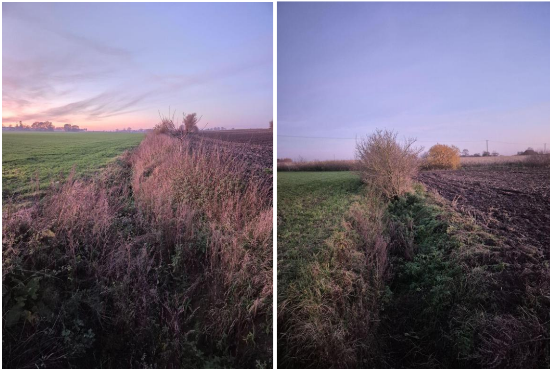
Fot. 6.4.2.7. Rów na dz. nr 86/1 obręb Czyżewo
