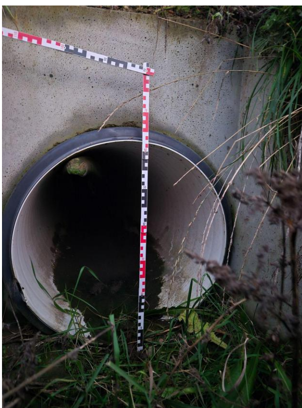
Fot. 6.4.2.6. Przepust pod drogą gruntową działka 85/2 i 89 obręb Czyżewo dno przepustu 106.908 m n.p.m. 53°05'20.8417" N, 19°20'14.8429" E.
