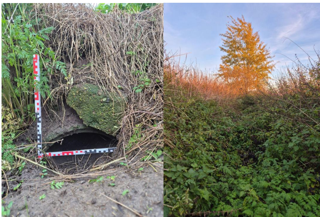
Fot. 6.4.2.2. Wlot do rurociągu biegnącego w kierunku północnym (po lewej); Rów otwarty na działce 9/3 obręb Czyżewo 53^{\circ}05'38.3883'' N, 19^{\circ}19'51.6083'' E, dno rowu - rzędna 109.317 m n.p.m (po prawej).
