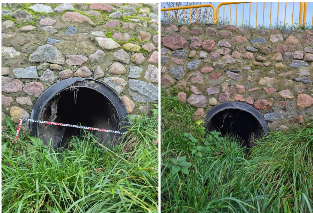
Fot. 6.4.2.1. Zestaw dwóch przepustów (pod drogą Długie – Rakowo, działka nr 8, i drugi pod ścieżką rowerową).
