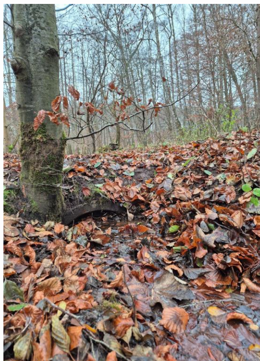
Fot. 6.4.2.4. Rów odprowadzający wody z Jeziora Leśnego II. Po prawej stronie widoczny wlot przepustu częściowo zamulony i zablokowany materiałem organicznym (liście, osady), powodujący ograniczenie drożności odpływu i lokalne piętrzenie wody.
