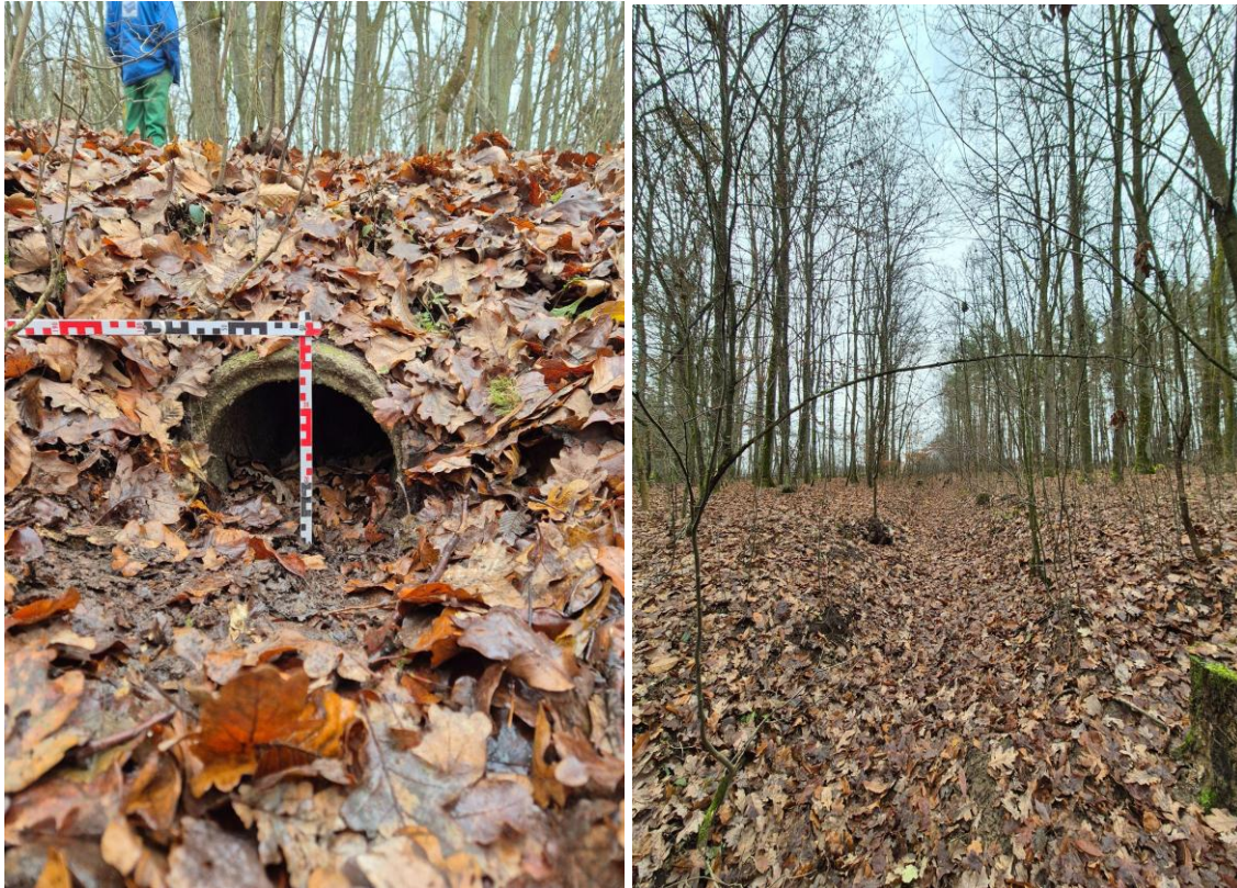
Fot. 6.4.1.3. Przepust i rów w części należącej do Lasów Państwowych na działce o nr 289/2.
