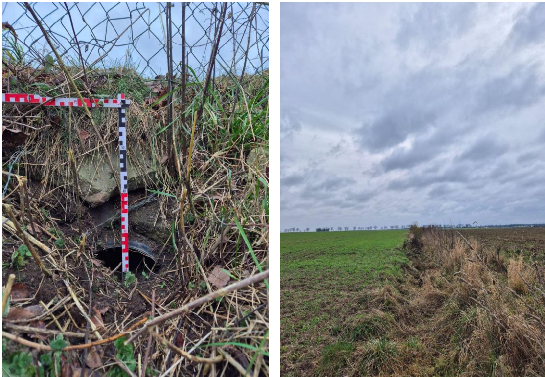
Fot. 6.4.1.3. Przepust na rowie R2-7 biegnący przez tereny uprawne.
