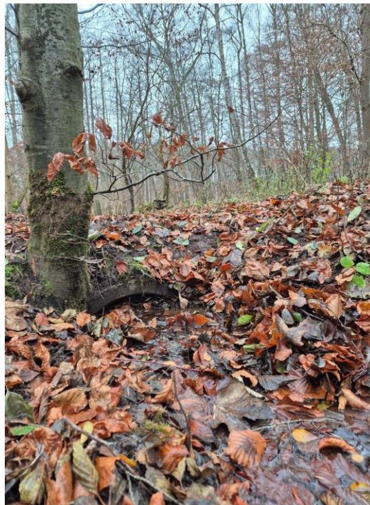
Fot. 6.4.2.4. Rów odprowadzający wody z Jeziora Leśnego II. Po prawej stronie widoczny wlot przepustu częściowo zamulony i zablokowany materiałem organicznym (liście, osady), powodujący ograniczenie drożności odpływu i lokalne piętrzenie wody.
