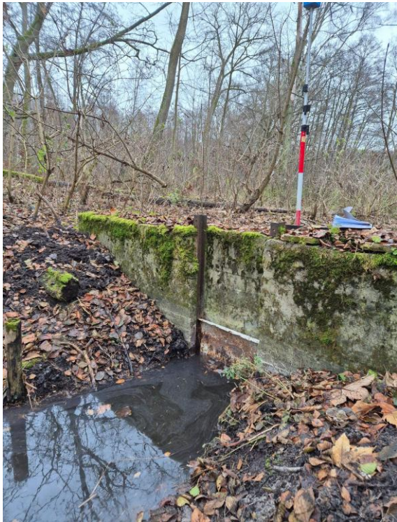
Fot. 6.4.2.3. Zastawka i rów na odpływie z jeziora Leśnego II.
