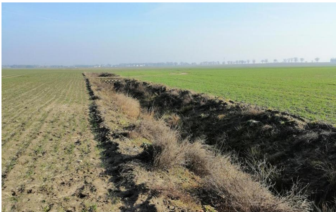
Fot. 6.4.1.2. Przebieg rowu melioracyjnego na działkach o nr ewid. nr 341/1, 338/1-a, 12 ( Raport...2019 , fot. 18.02.2019 r.).
