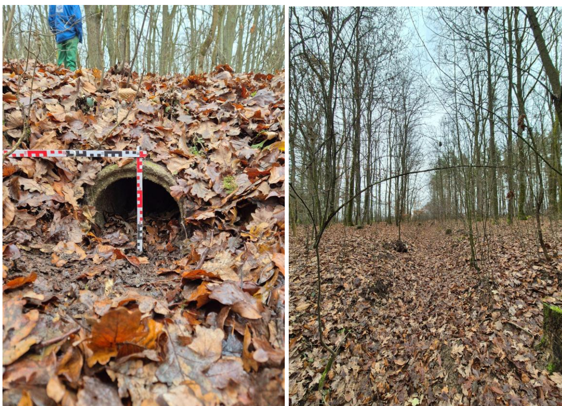
Fot. 6.4.1.3. Przepust i rów w części należącej do Lasów Państwowych na działce o nr 289/2.
