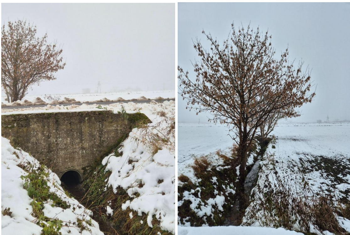
Fot. 6.4.2.7. Przepust pod ulicą Akacjową oraz rów poniżej ulicy Akacjowej, gdzie wchodzi w rurociąg.
