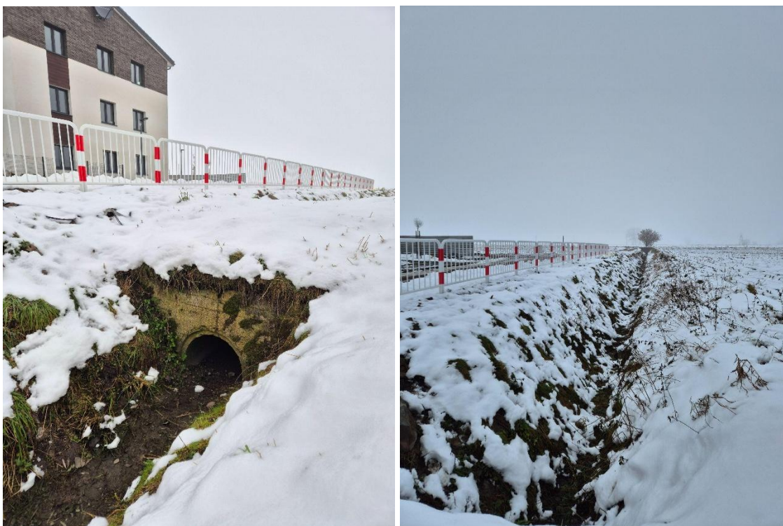
Fot. 6.4.2.6 .Rów poniżej projektowanego zbiornika.
