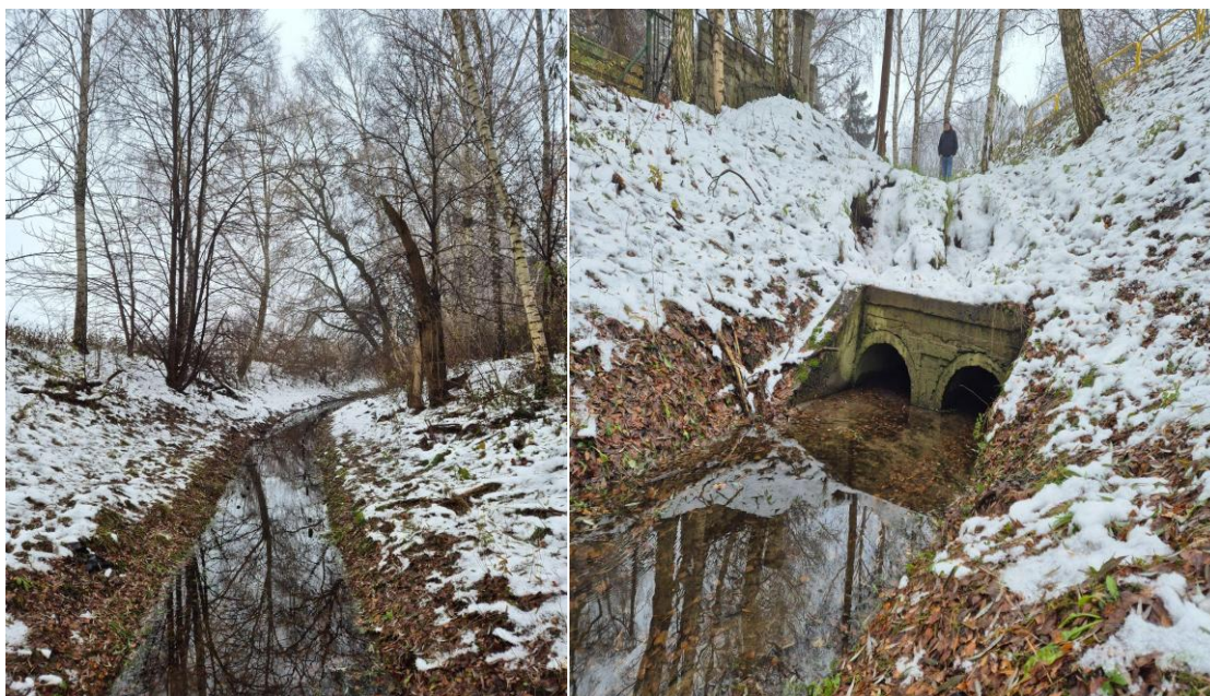
Fot. 6.4.1.4. Ciek i przepust poniżej planowanej inwestycji.
