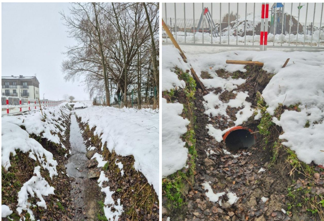
Fot. 6.4.2.4. Rów powyżej projektowanego zbiornika (fotografia po lewej). Wylot z kanalizacji deszczowej powstającego osiedla (fotografia po prawej).
