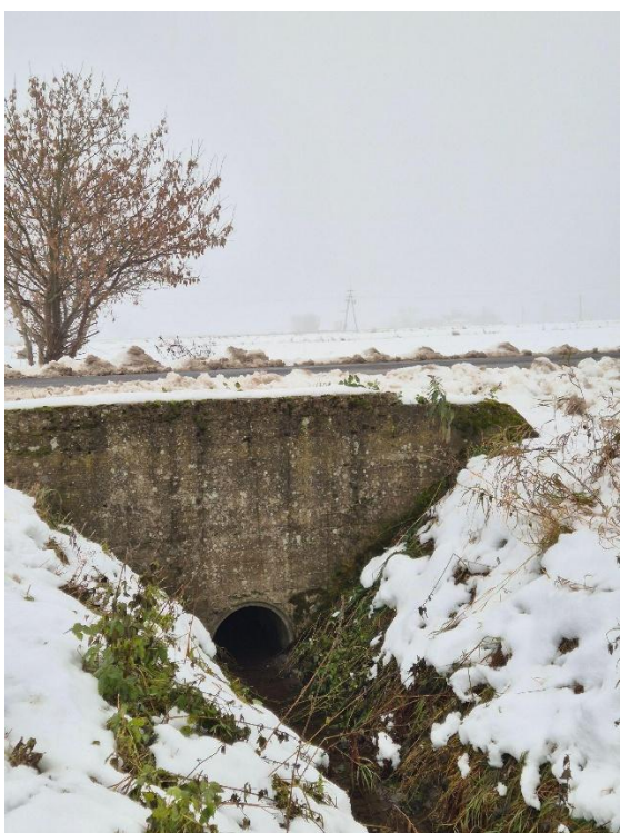
Fot. 6.4.2.7. Przepust pod ulicą Akacjową oraz rów poniżej ulicy Akacjowej, gdzie wchodzi w rurociąg.
