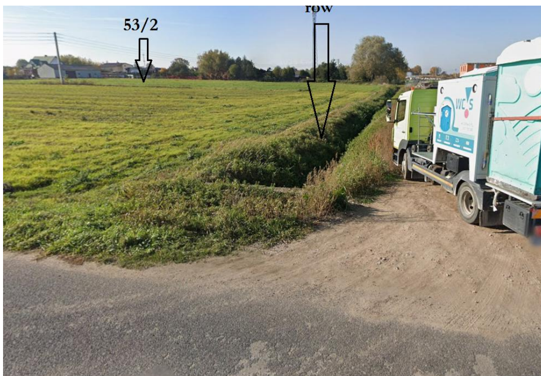
Fot. 6.4.2.3. Widok na działkę nr 53/2, działkę drogową nr 53/6 oraz rów przed wlotem do przepustu.
