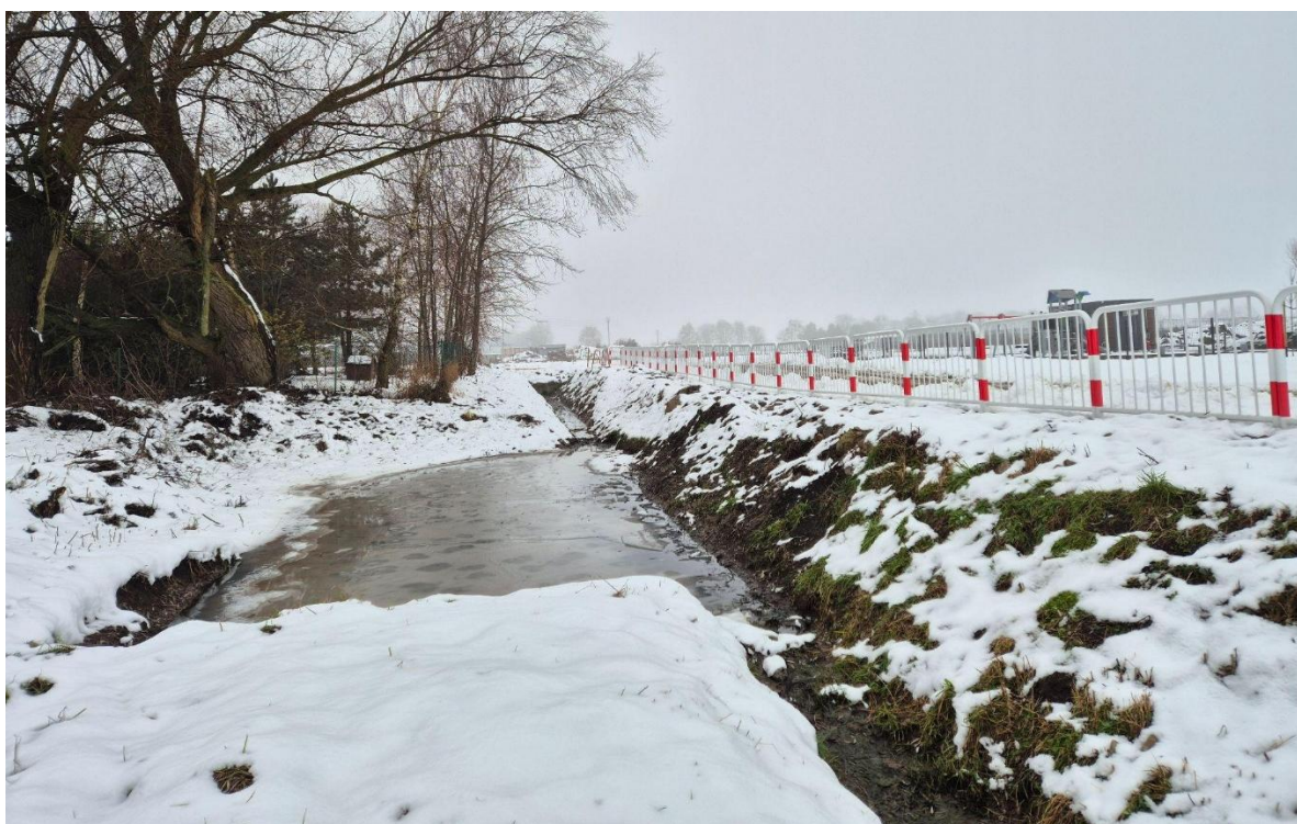
Fot. 6.4.2.5. Rów powyżej projektowanego zbiornika
