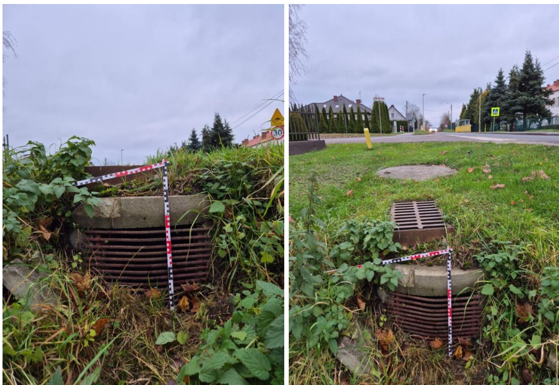
Fot. 6.4.2.2. Przepusty i wloty do kanalizacji deszczowej przy ul Sępoleńskiej, m. Gostycyn.
