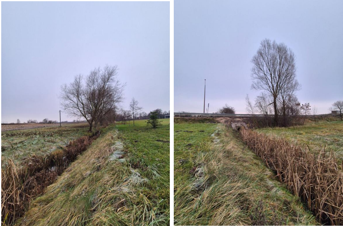
Fot. 6.4.1.1. Rów melioracyjny Wh, na działce 8/2 obręb 0007 Wąbrzeźno.
