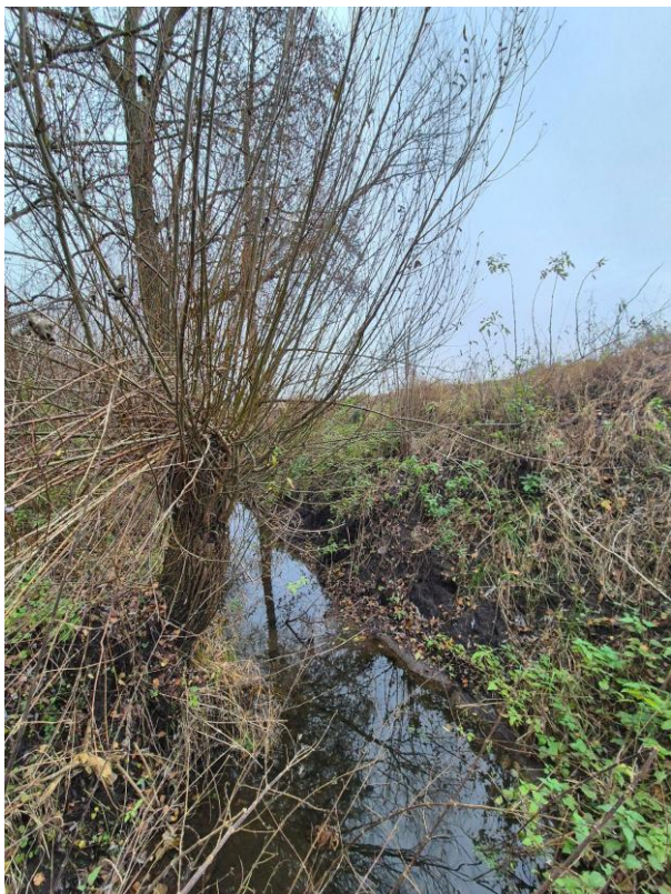
Fot.6.4.1.4. Rów poniżej wylotu z przepustu na działce 25, obręb 0007.
