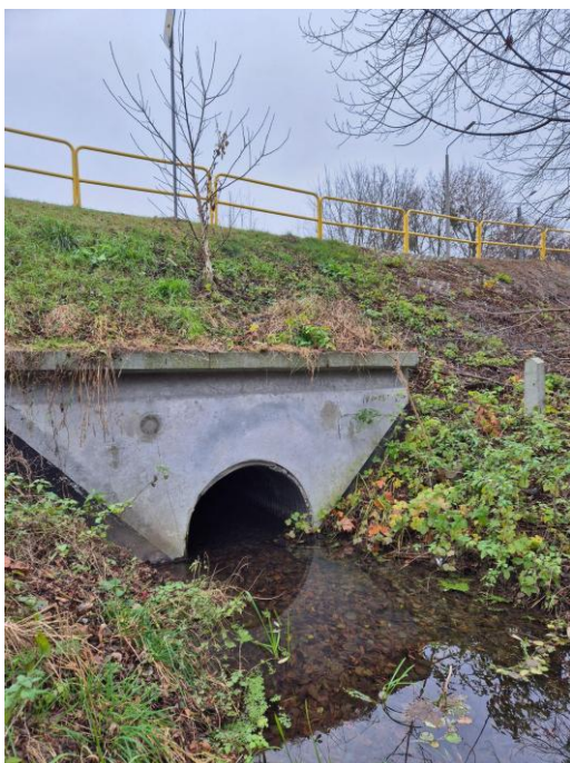
Fot.6.4.1.6. Przepust na odpływie z J. Frydek, przed przebudową dno było wyżej i nieco podpiętrzało jezioro. Dno przepustu = 92.913 m n.p.m. ( 53^{\circ}16'11.7209''N 18^{\circ}56'48.4091''E ) lustro wody = 93.444 m n.p.m.
