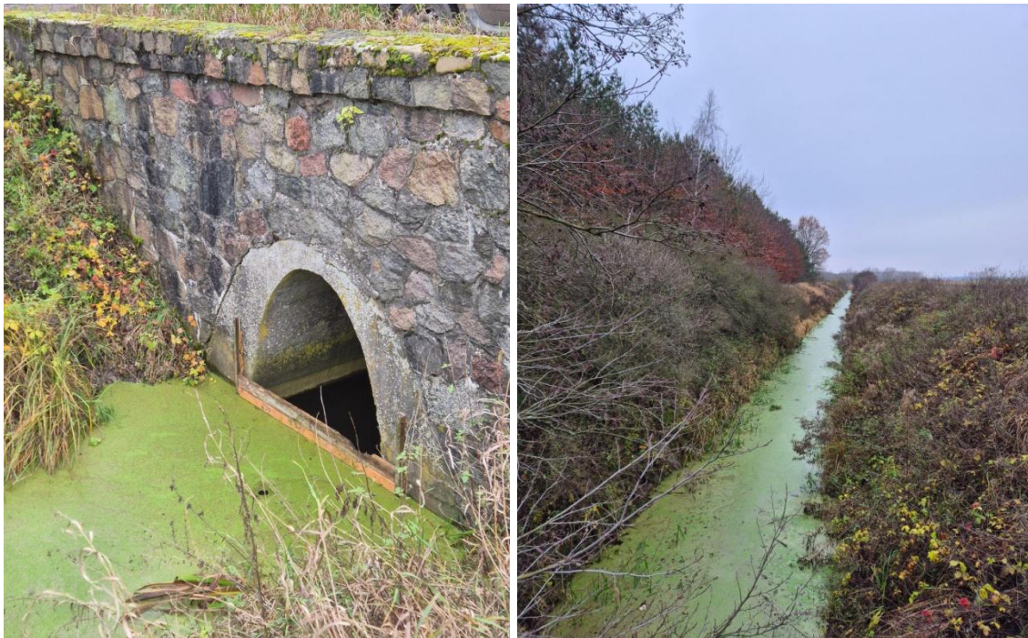
Fot. 6.4.2.3. Przepust na cieku Struga Toruńska dz. nr 10, obręb Ryńsk, 53^{\circ}14'48.9589''N 18^{\circ}48'14.0274''E - dno przepustu = 88.485 m n.p.m., lustro wody poniżej zastawki = 89.179 m n.p.m., lustro wody powyżej zastawki = 89.339 m n.p.m.
