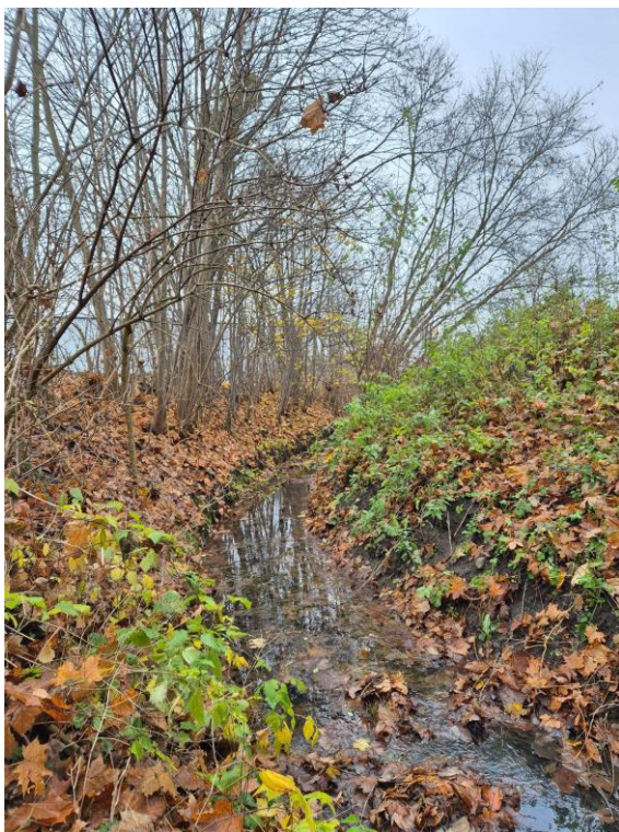
Fot.6.4.1.5. Przepust na rowie Wh oraz fragment rowu powyżej przepustu na działce 25, obręb 0007, dno przepustu = 94.204 m n.p.m. ( 53^{\circ}16'35.5234''N 18^{\circ}56'40.7824''E ), lustro wody = 94.535 m n.p.m.
