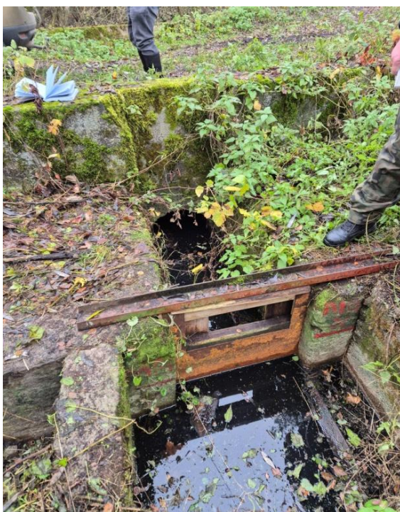
Fot. 6.4.2.2. Zastawka na cieku wypływającym z Jeziora na działce 3/4 obręb Ryńsk. Pomierzone rzędne lustra wody poniżej zastawki = 89.659 m n.p.m. ( 53^{\circ}14'54.5959''N 18^{\circ}48'18.4732''E ), dno przepustu = 89.526 m n.p.m., lustro wody powyżej zastawki = 89.729 m n.p.m.
