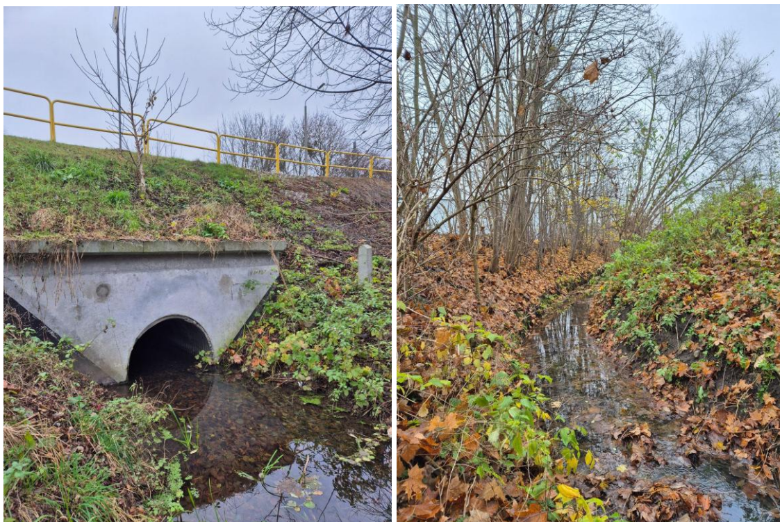
Fot. 6.4.1.6. Przepust na odpływie z J. Frydek, przed przebudową dno było wyżej i nieco podpiętrzało jezioro. Dno przepustu = 92.913 m n.p.m. ( 53^{\circ}16'11.7209''N 18^{\circ}56'48.4091''E ) lustro wody = 93.444 m n.p.m.
