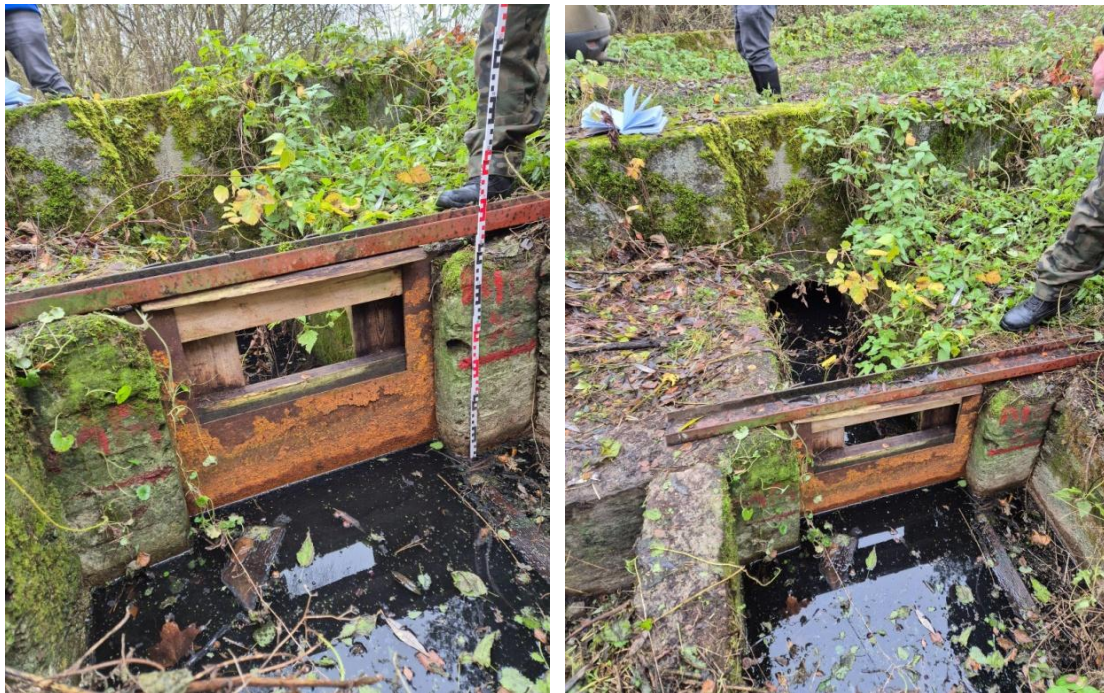
Fot. 6.4.2.2. Zastawka na cieku wypływającym z Jeziora na działce 3/4 obręb Ryńsk. Pomierzone rzędne lustra wody poniżej zastawki = 89.659 m n.p.m. ( 53^{\circ}14'54.5959''N 18^{\circ}48'18.4732''E ), dno przepustu = 89.526 m n.p.m., lustro wody powyżej zastawki = 89.729 m n.p.m.
