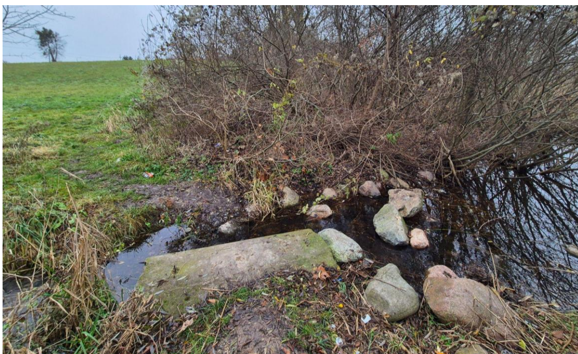
Fot. 6.4.1.7. Prowizoryczna blokada odpływu z jeziora Frydek.
