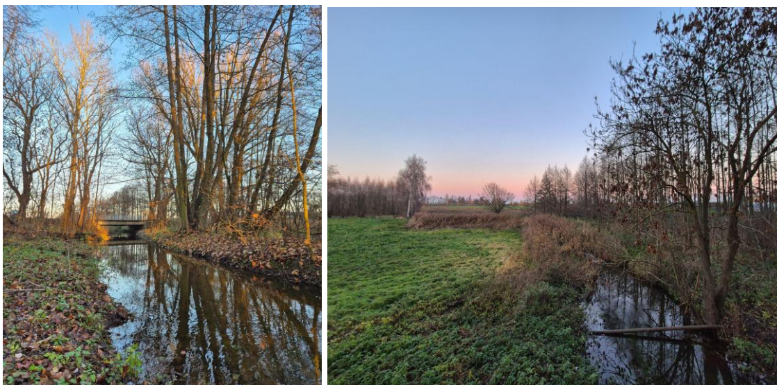
Fot. 6.4.1.2. Rzeka Lubieńka - widok na most na drodze powiatowej 2921C oraz widok poniżej mostu. Rzędna lustra wody = 90.188 m n.p.m.
