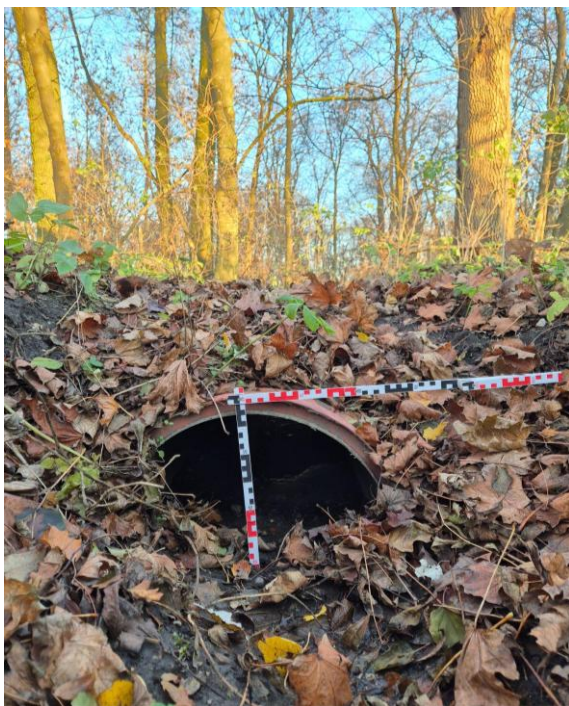
Fot. 6.4.1.4. Przepust pod ścieżką rowerową. Rzędna dna przepustu = 91.258 m n.p.m. (52°31'11.1178"N 19°00'54.1633"E).
