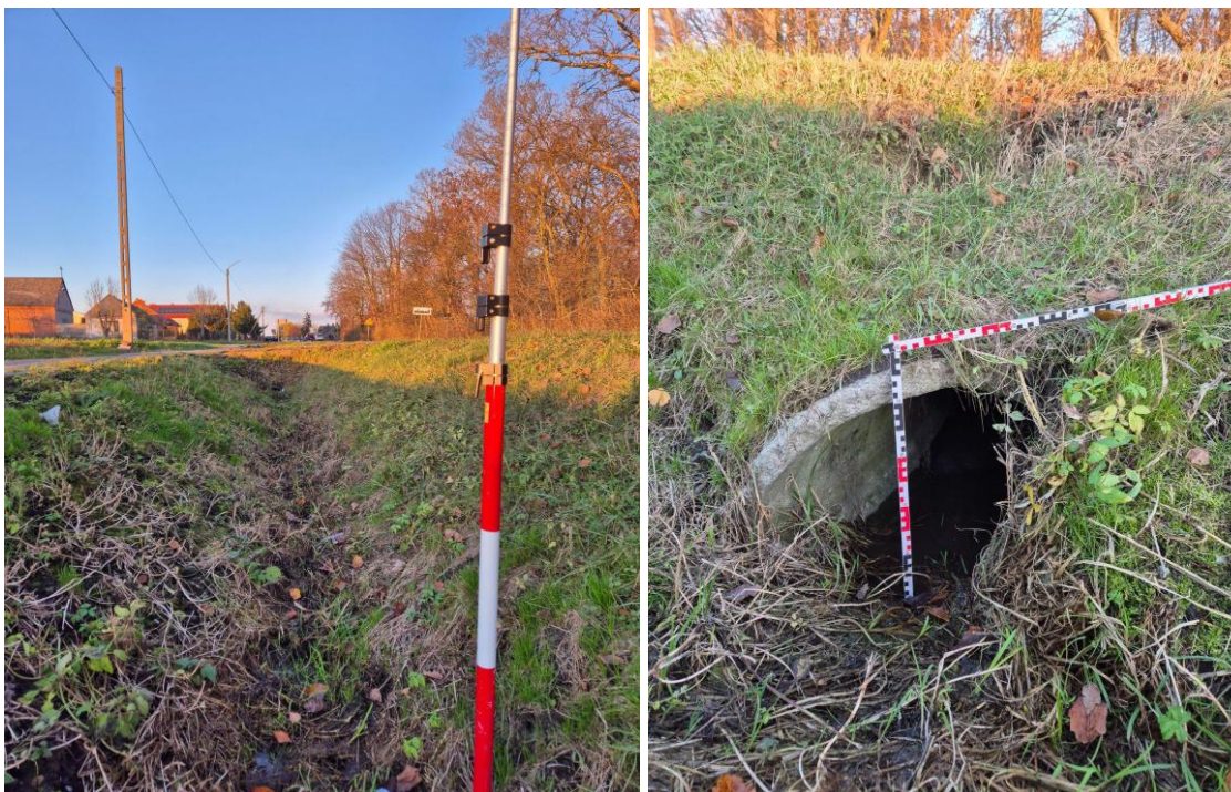
Fot. 6.4.1.3. Koryto rowu przy drodze gminnej nr 2909C; po stronie wschodniej rów łączy się z wodami rzeki Lubieńki w miejscu położonym powyżej planowanej inwestycji, natomiast po stronie zachodniej przebiega przepustem pod drogą nr 2909C; rzędna dna przepustu: 91,681 m n.p.m. (52°31'11.1704"N, 19°00'53.3291"E).
