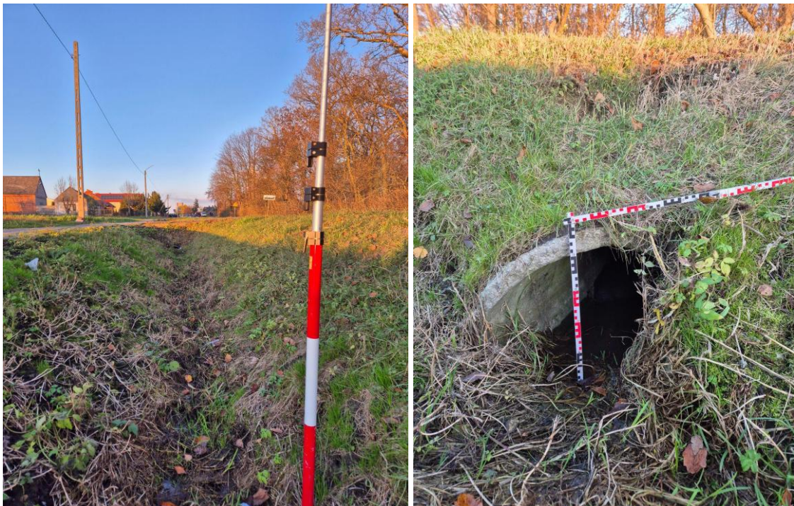
Fot. 6.4.1.3. Koryto rowu przy drodze gminnej nr 2909C; po stronie wschodniej rów łączy się z wodami rzeki Lubieńki w miejscu położonym powyżej planowanej inwestycji, natomiast po stronie zachodniej przebiega przepustem pod drogą nr 2909C; rzędna dna przepustu: 91,681 m n.p.m. ( 52^{\circ}31'11.1704''N , 19^{\circ}00'53.3291''E ).
