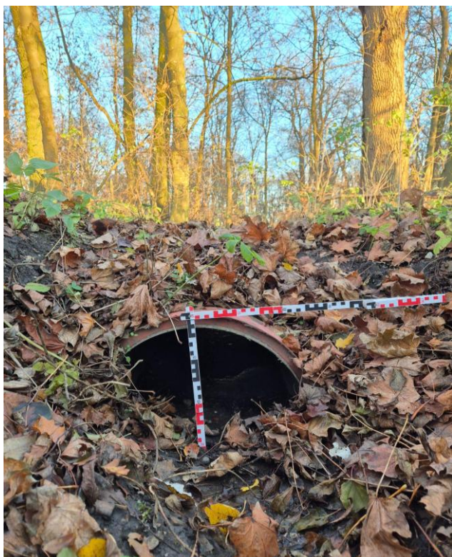
Fot. 6.4.1.4. Przepust pod ścieżką rowerową. Rzędna dna przepustu = 91.258 m n.p.m. ( 52^{\circ}31'11.1178''N 19^{\circ}00'54.1633''E ).
