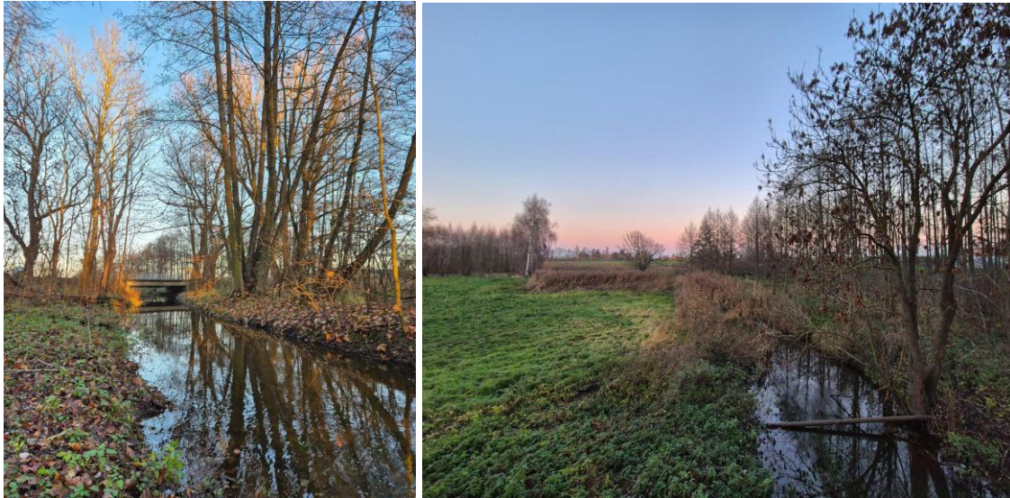
Fot. 6.4.1.2. Rzeka Lubieńka – widok na most na drodze powiatowej 2921C oraz widok poniżej mostu. Rzędna lustra wody = 90.188 m n.p.m.
