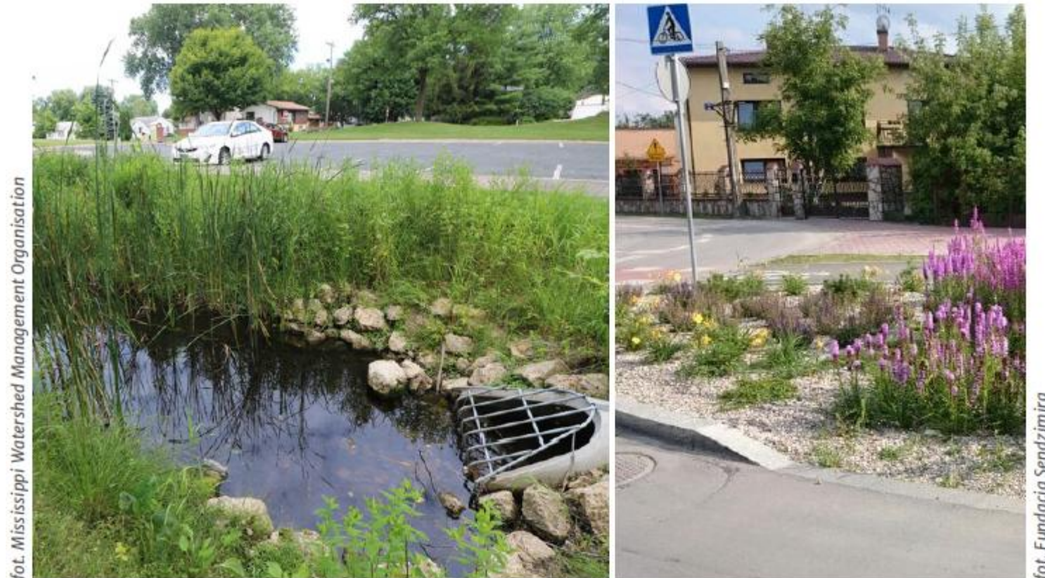
Rysunek 3. Niecka bioretencyjna, Labelle Park, Columbia Heights, Minnesota, Stany Zjednoczone (po lewej); niecka w formie ronda filtrującego, Marki k. Warszawy, Polska (po prawej)
